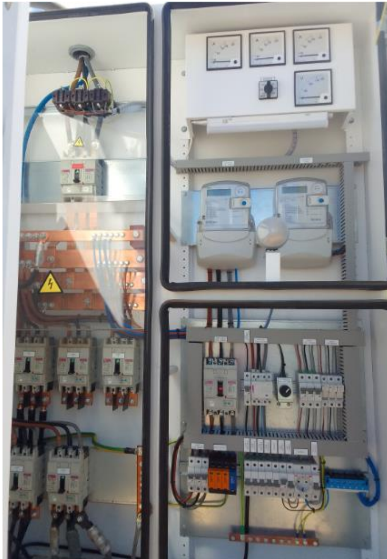
Figura AP10-12: Visualização de um QGBT de quadro aberto CA2 de um PTD [Fonte: Autor do projecto].
