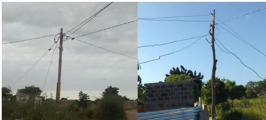
Figura 27. IP e rede de distribuição em BT do bairro Boquisso "B", Q12 [Fonte: Autor do projecto]
