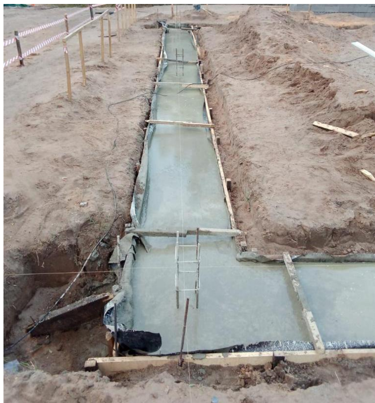
Figura 19: Cofragem recuperável em madeira de pinho (Fonte: Autor)
