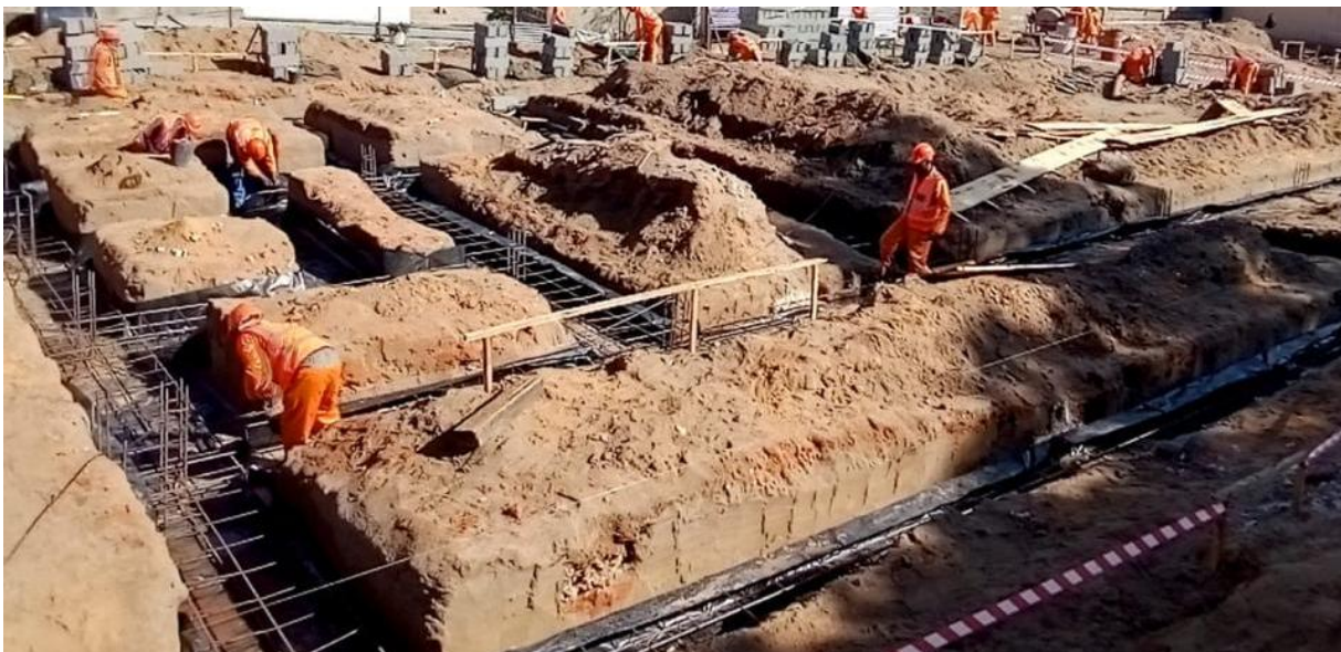
Figura 18: Trabalhos de Amarração da armadura da fundação. (Fonte: Autor)
