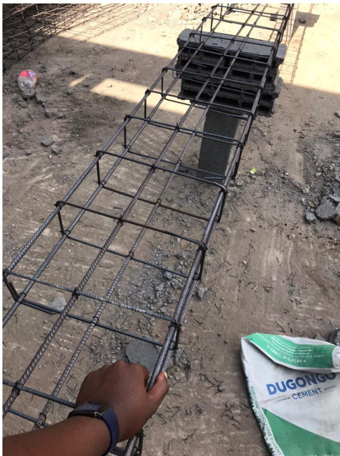
Figura 15: Armadura das vigas e pilares (fonte: Autor)
