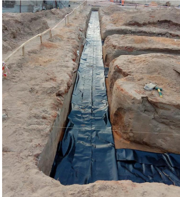
Figura 14: Colocação da membrana de impermeabilização em plástico na fundação (Fonte: Autor)
