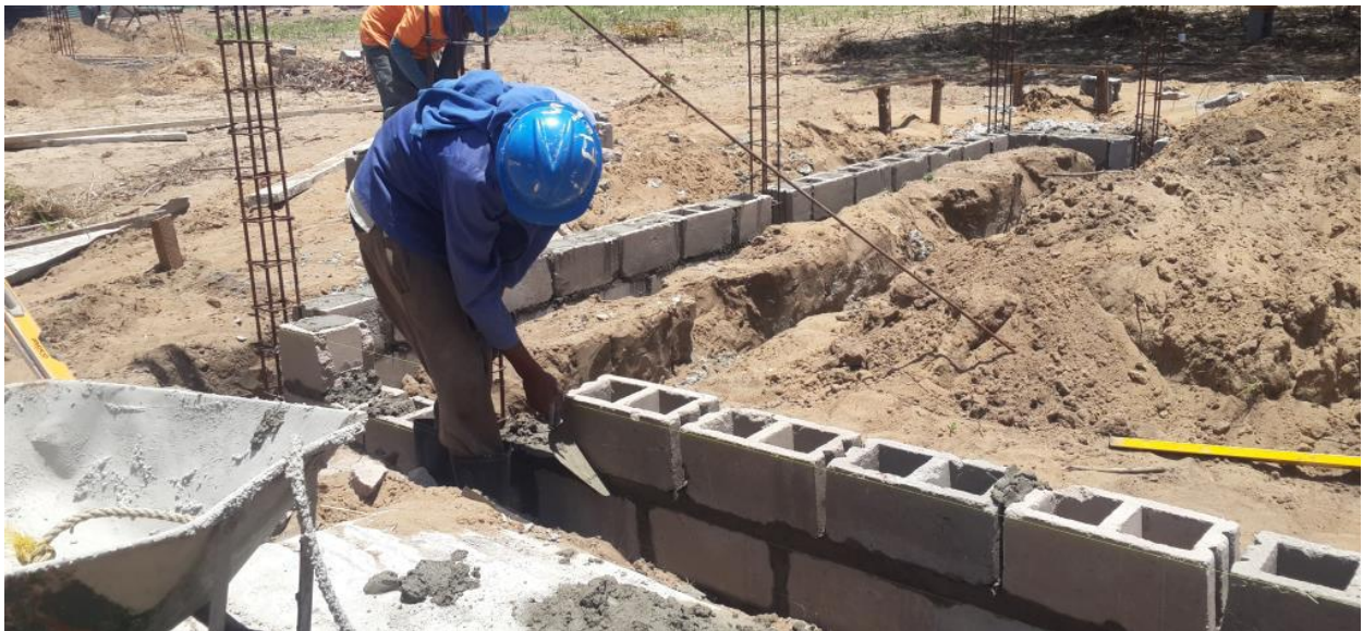
Figura 21: Alinhamento dos blocos para as paredes (Fonte: Autor)
