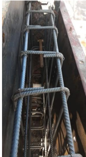
Figura 8: Ilustração da amarração do varão (Fonte: Autor)
