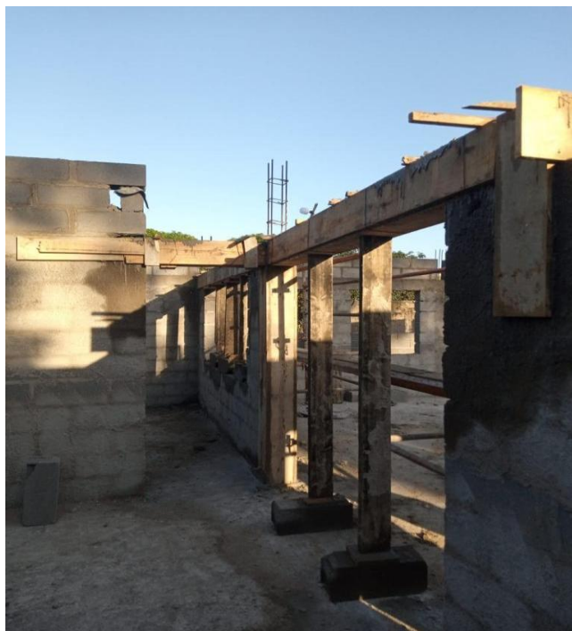
Figura 22: Betonagem das vigas (Fonte: Autor)
