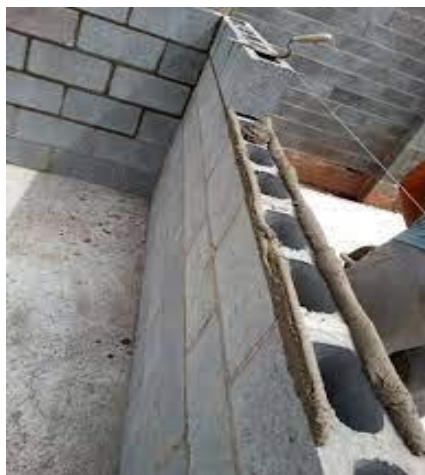
Figura 2: alvenaria não estrutural
