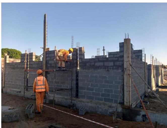
Figura 23: cofragem de pilares e escoramento(Fonte:autor)
