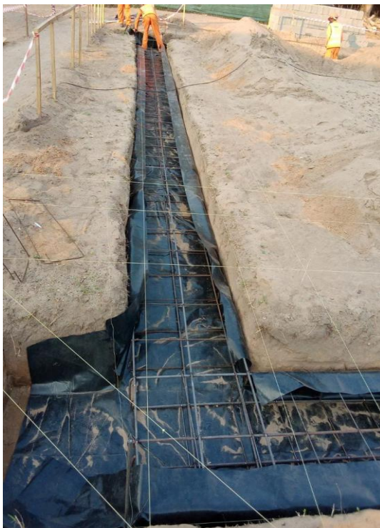
Figura 16: Colocação e amarração dos varões perpendiculares para a fundação (fonte: Autor)
