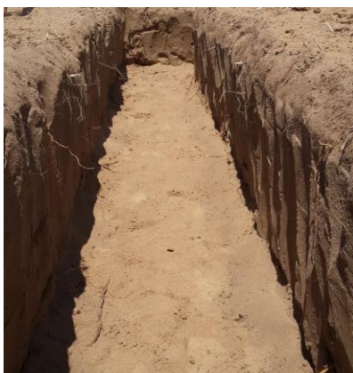
Figura 13: Cabouco aberto para execução da fundação (fonte: Autor)
