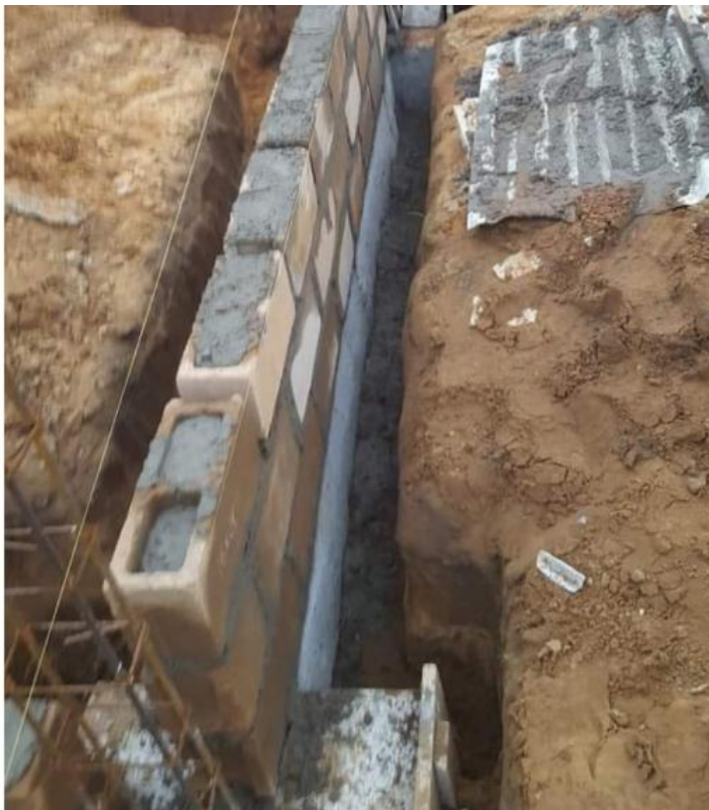
Figura 20: Alvenaria estrutural nas fundações (Fonte: Autor)
