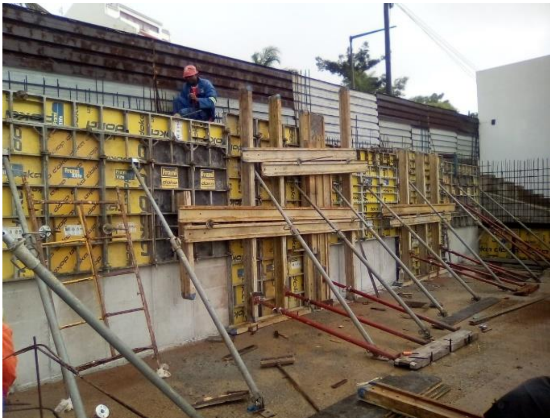
Figura 11: Colocação de taipais e escoramento do muro (fonte - autor)
