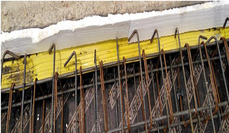
Figura 23: Tratamento das juntas de dilatação (fonte - autor)
