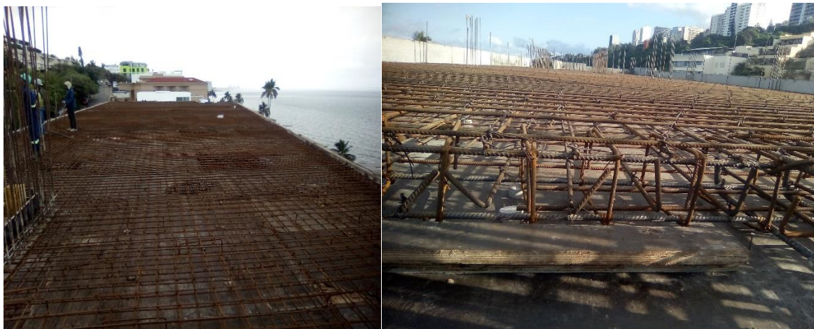
Figura 18: Amarração da malha superior da armadura (fonte - autor)
