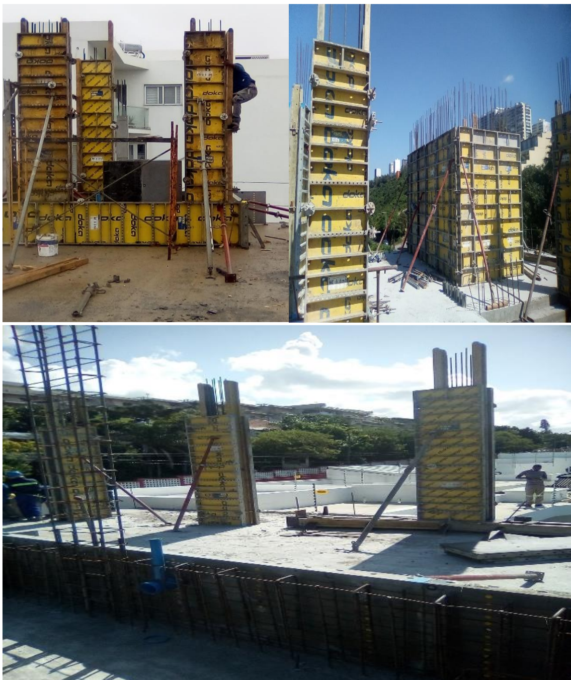
Figura 12: Cofragem de pilares, núcleo do elevador e piscinas ( fonte - autor)
