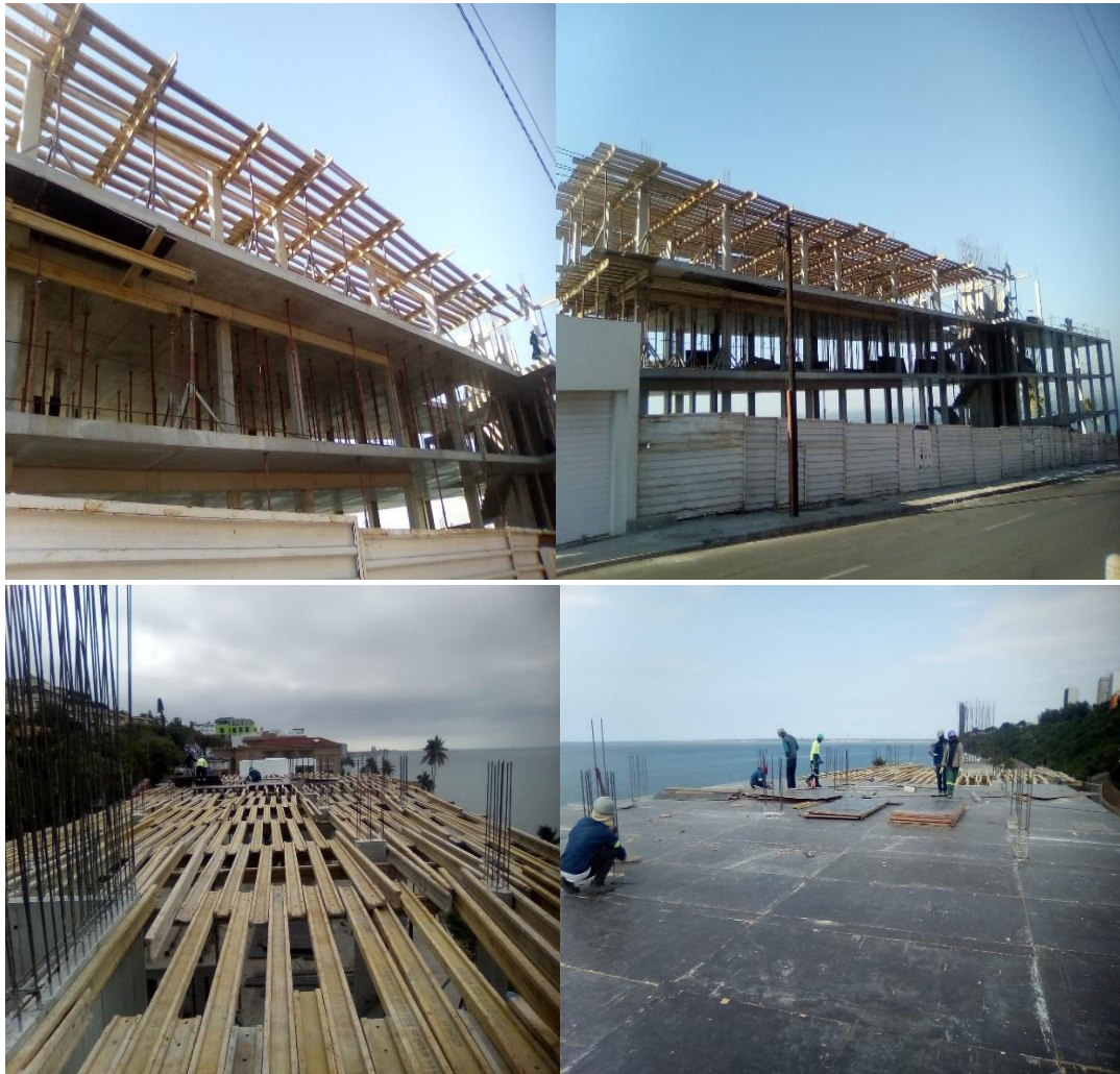
Figura 15: Colocação de prumos, vigotas principais e secundárias, e assoalho das chapas de cofragem sobre as vigotas (fonte - autor)
