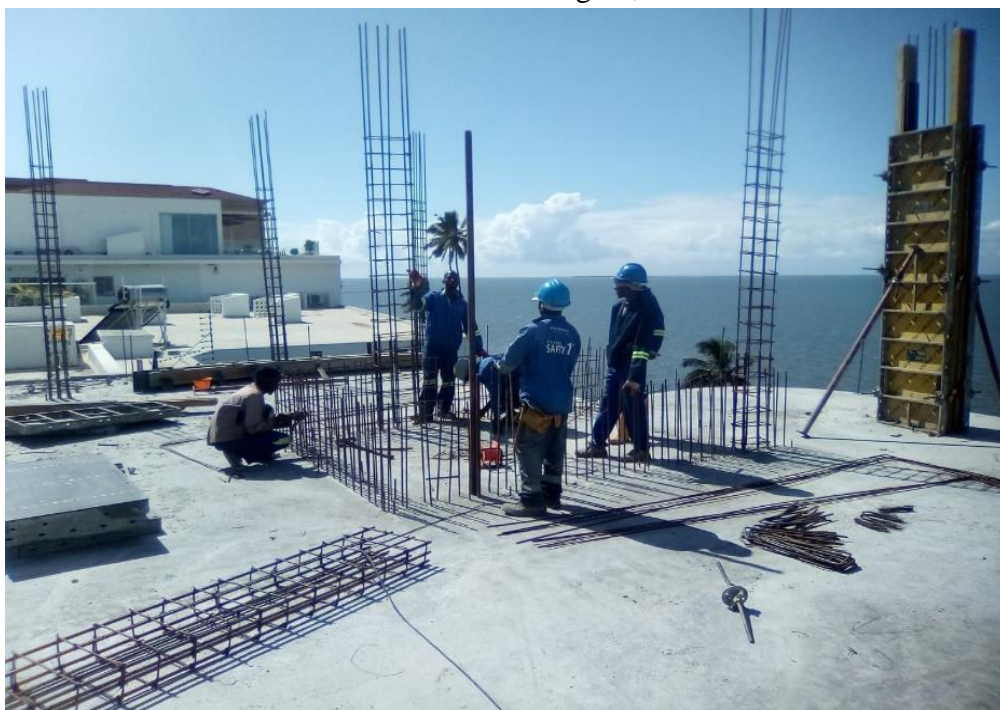
Figura 9: Empalme e amarração das armaduras dos pilares(fonte – autor)
