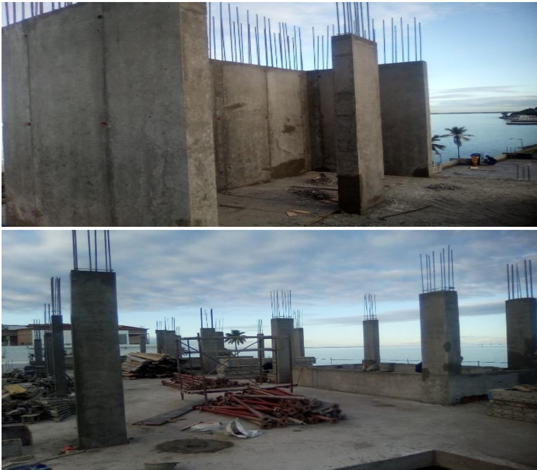
Figura 14: Descofragem dos elementos verticais (fonte - autor)
