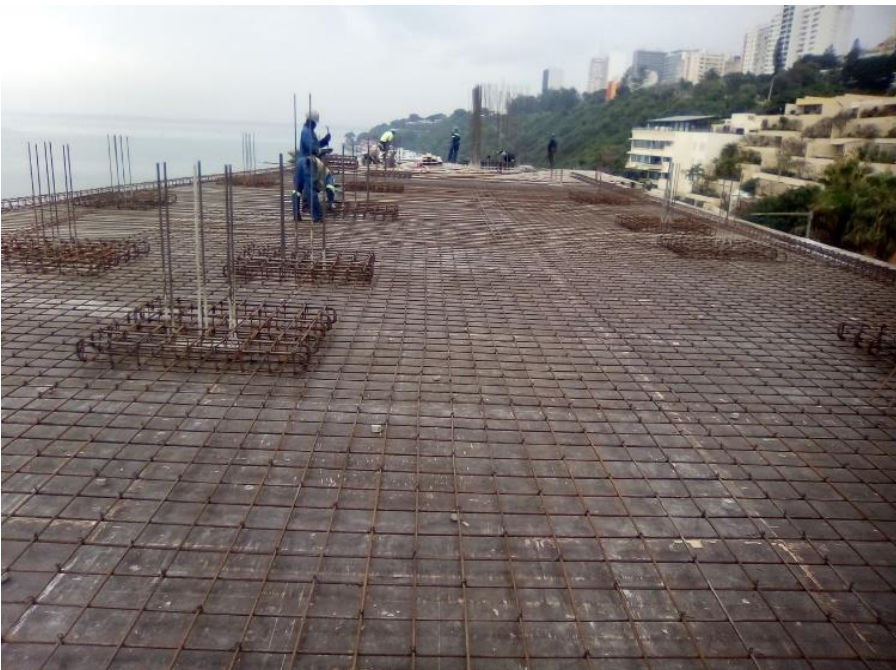
Figura 17: Amarração da malha inferior da armadura e colocação da armadura de punçoamento (fonte - autor)
