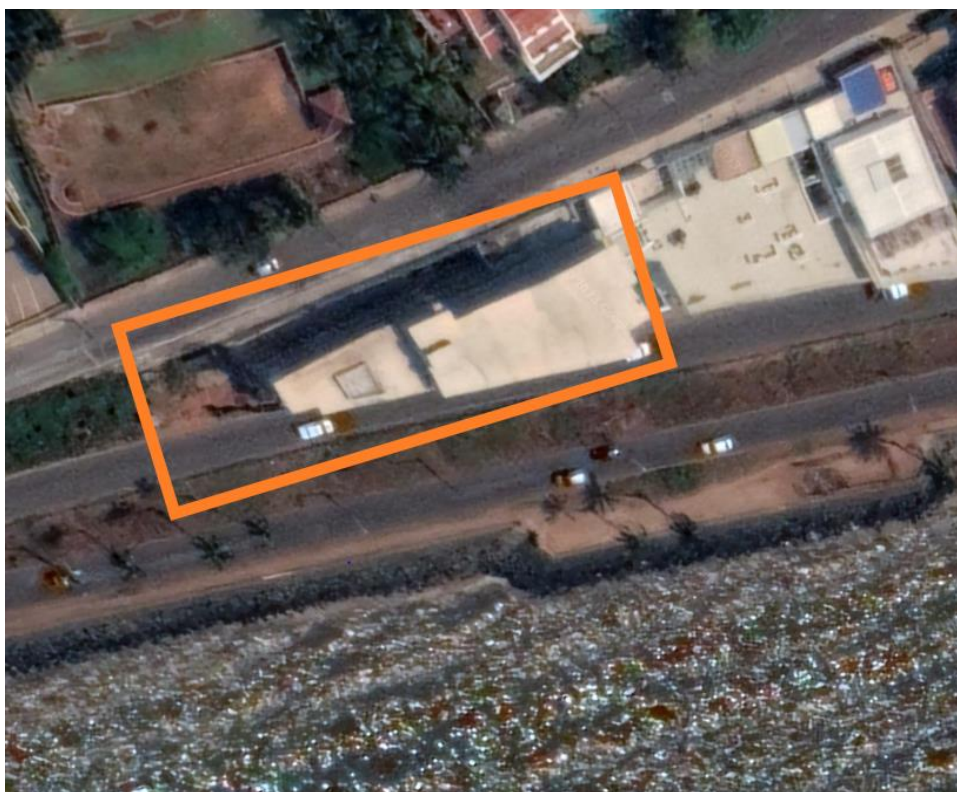
Figura 6: Imagem da localização do canteiro de obra pelo Google Earth (fonte - autor)
