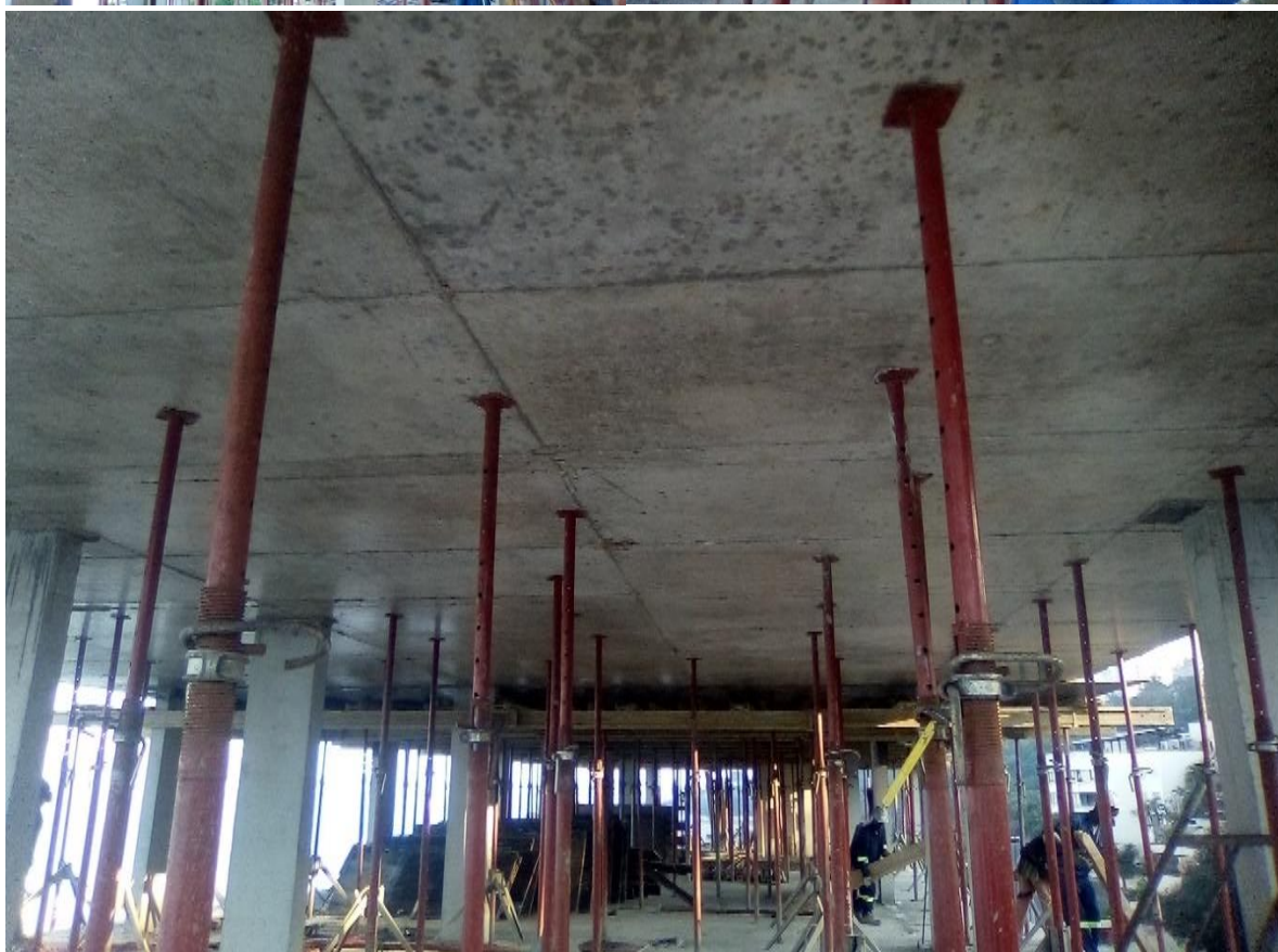
Figura 22: Descobragem e escoramento da laje (fonte - autor)
