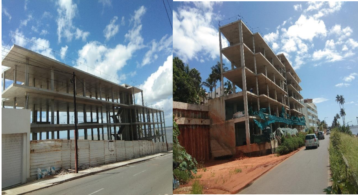
Figura 26: Edifício após a execução (fonte - autor)
