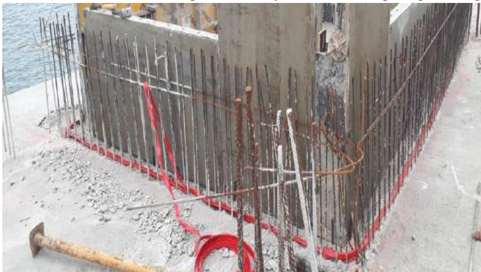
Figura 24: Tratamento das piscinas para evitar infiltrações (fonte - autor)
