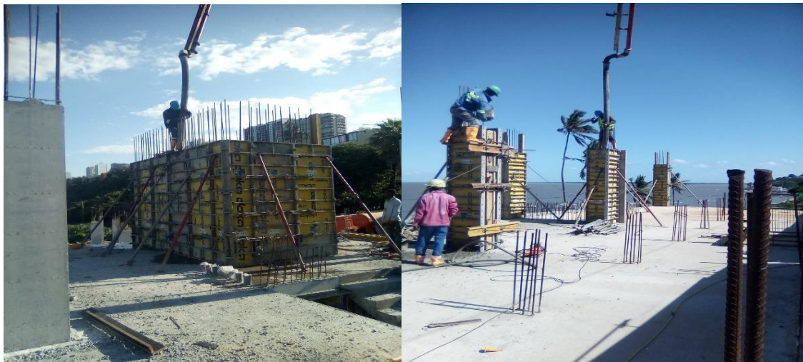
Figura 13: Betonagem dos elementos verticais com o auxílio de uma tromba da bomba de betão (fonte - autor)
