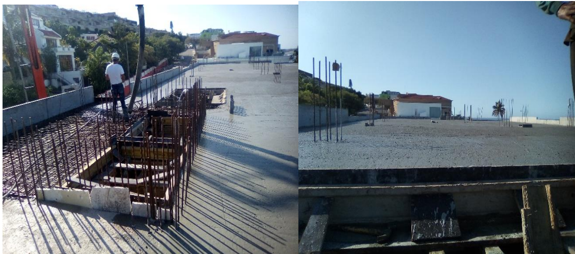
Figura 19: Betonagem da laje com o auxílio de uma bomba (fonte - autor)
