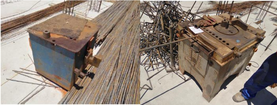
Figura 16: Máquina para moldar e dobrar o aço em obra (fonte - autor)
