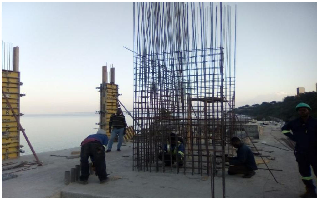
Figura 10: Empalme e amarração da armadura do núcleo do elevador (fonte - autor)
