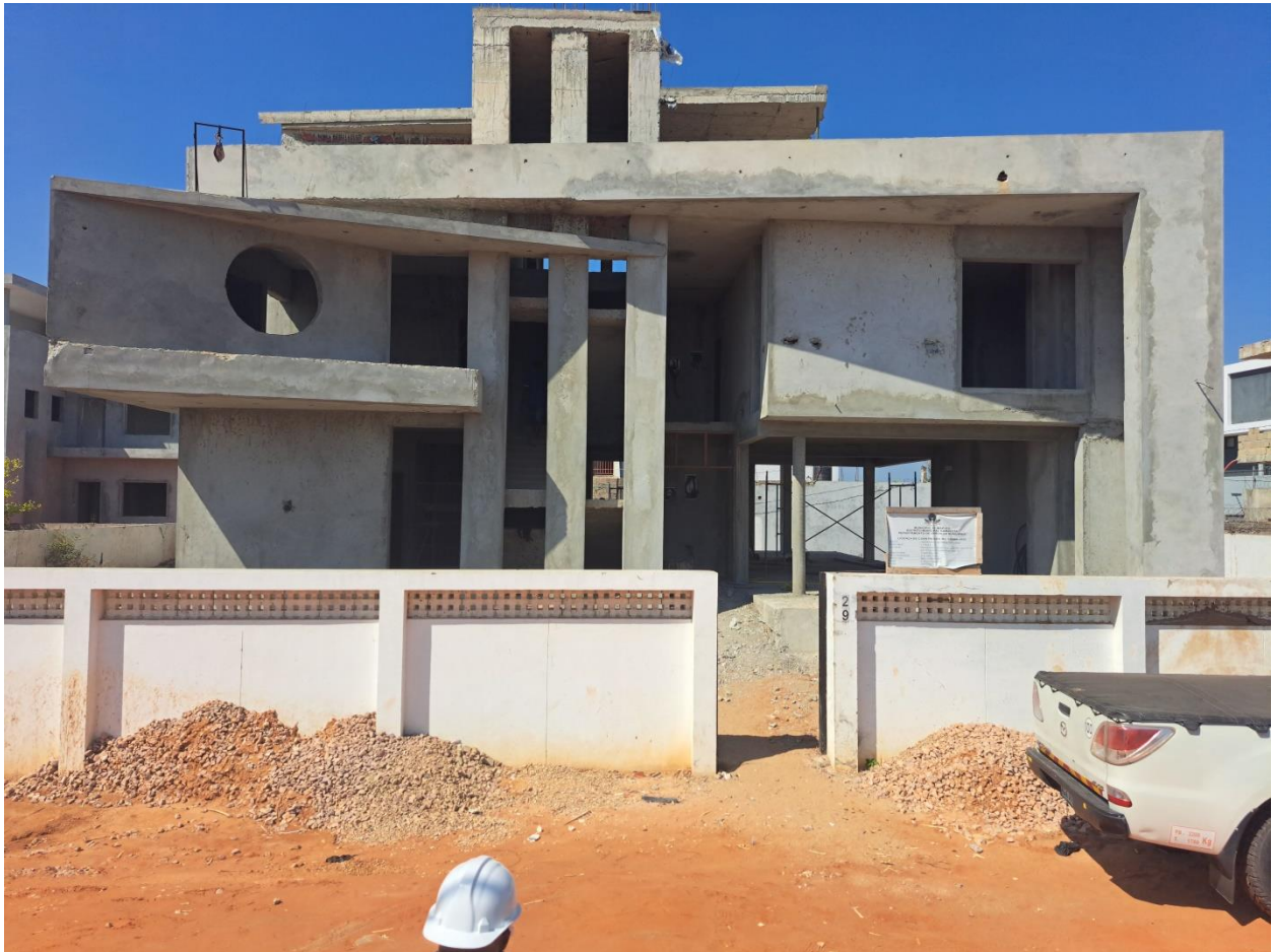
Figura 18. Vista geral do edifício.
