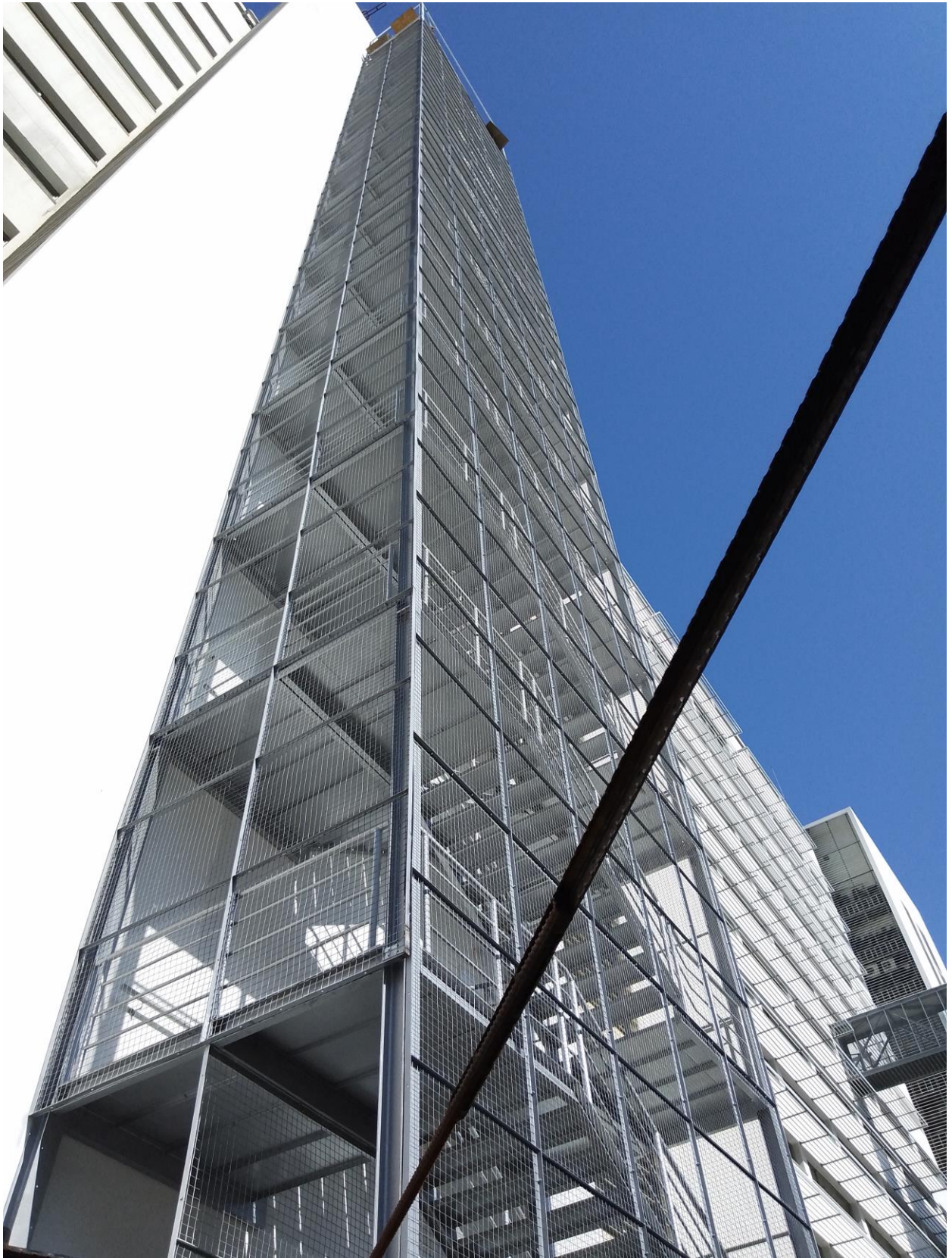
Figura 25. Vista Geral de escada de emergência.
