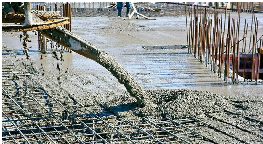
Figura 5. Betonagem de laje de Betão Armado.
