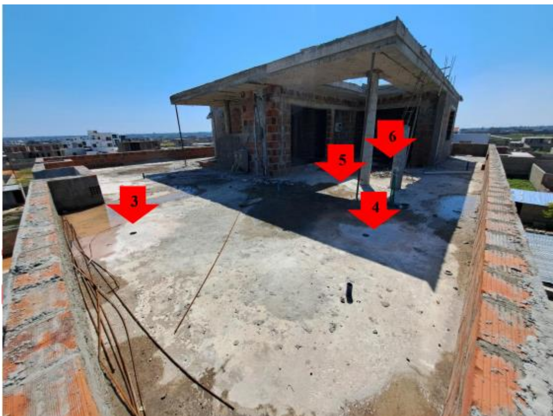
Figura 20. Vista geral dos pontos e extracção de carotes.
