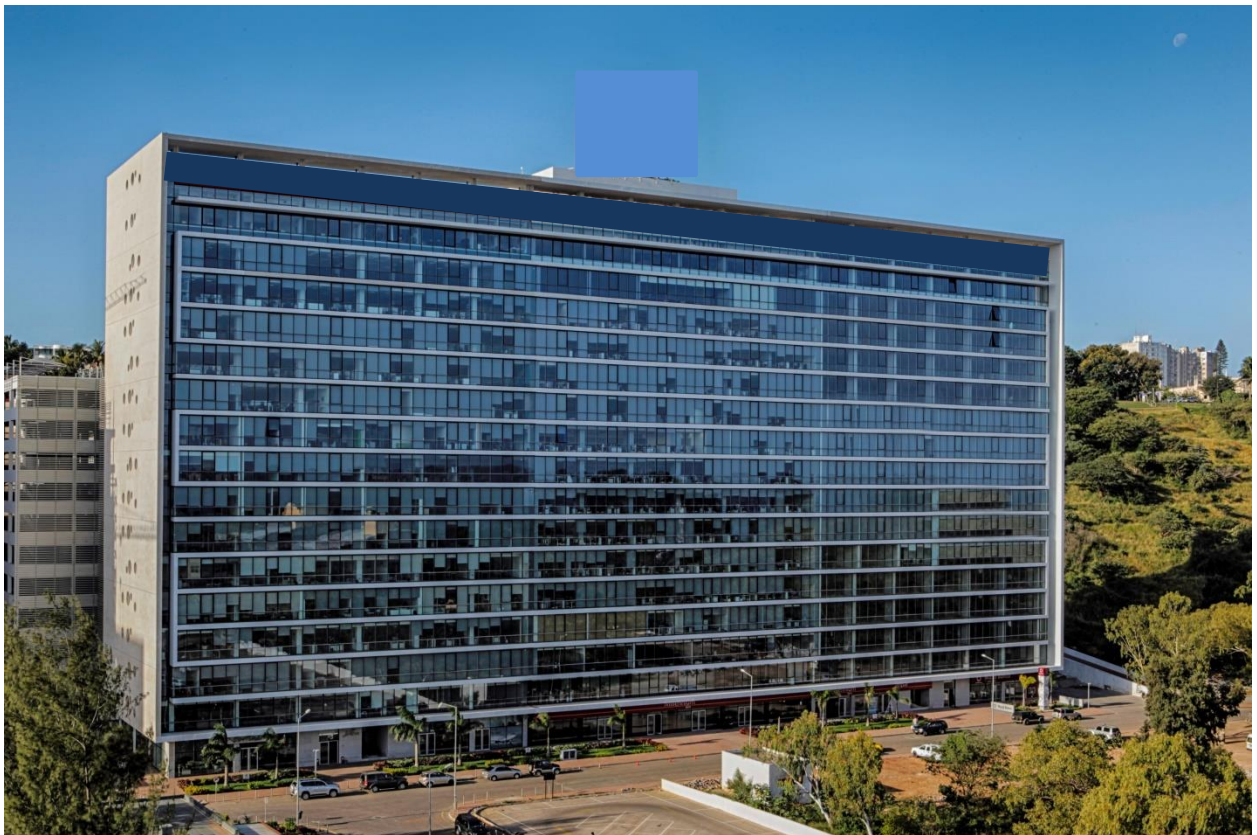
Figura 24. Vista Geral do edifício em estudo.
