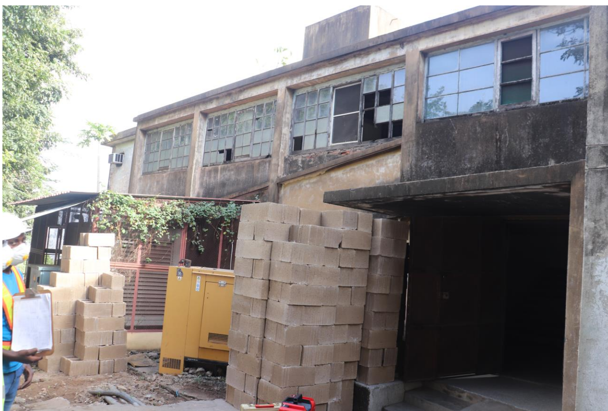
Figura 31. Vista Geral do edifício em estudo.
