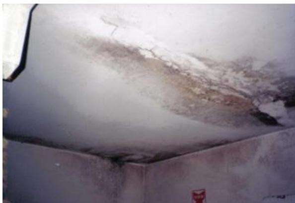
Figura 17. Infiltração nas paredes proveniente da cobertura (Fonte: Carvalho, 2015).
