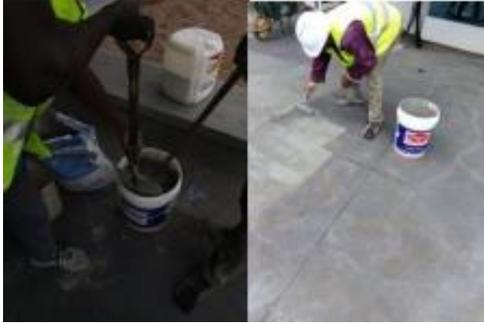
**Figura 32. Mistura de TALBOND com a argamassa e pintura do terraço. (Fonte: Estagiário).**
