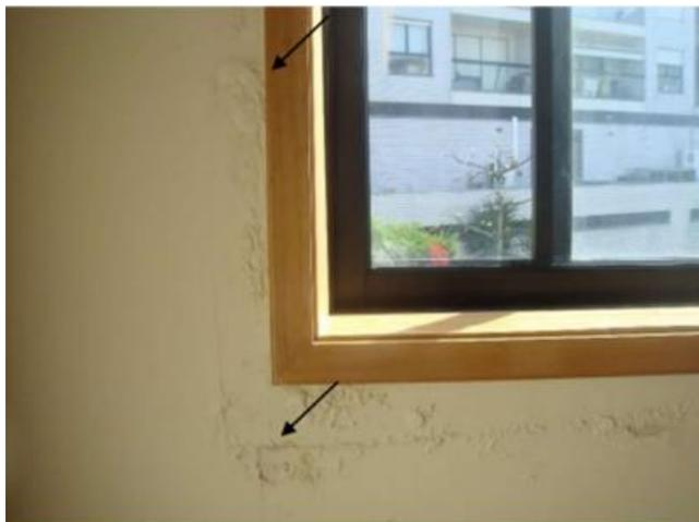
Figura 16. Fenômeno da Humidade por Infiltração (Fonte: Marinho, 2014).
