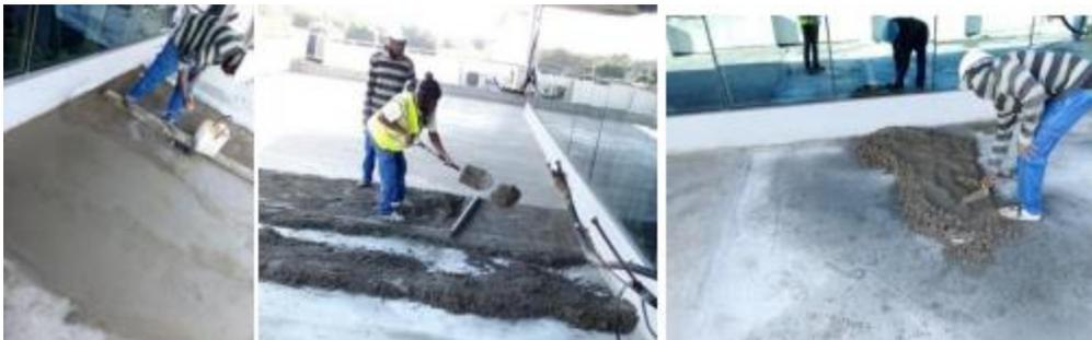
**Figura 35. Lançamento e nivelamento da argamassa ao nível das fasquias. (Fonte: Estagiário).**
