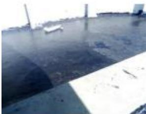
Figura 39. Aparência final após a aplicação do asfalto. (Fonte: Estagiário).
