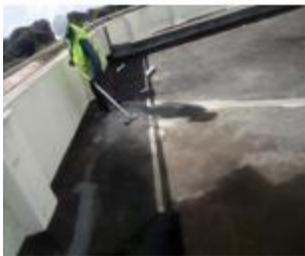
**Figura 31. Limpeza da superfície a regularizar (Fonte: Estagiário).**
