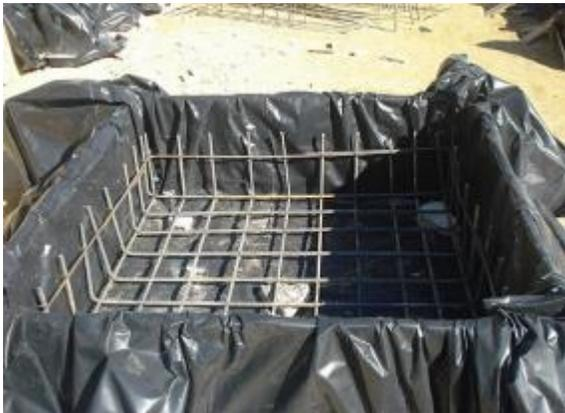
**Figura 18. Impermeabilização da sapata (Fonte: Mendes, 2011).**
