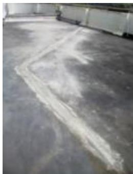
Figura 22. Cortes na laje de cobertura para condução de águas pluviais aos tubos de queda. Fonte: Estagiário
