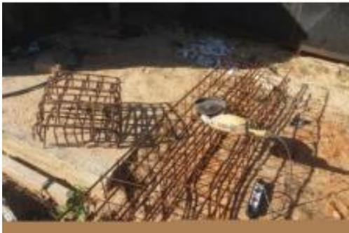
**Figura 58. Armadura para sapatas, pilares e vigas. (Fonte: Estagiário).**
