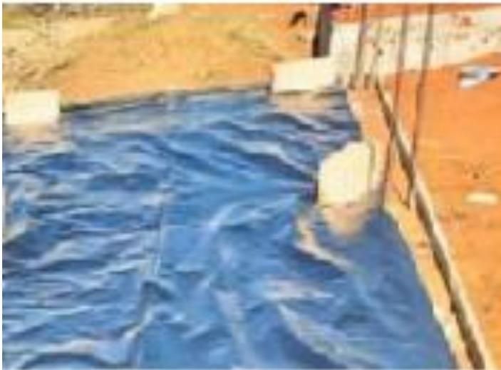
**Figura 57. Impermeabilização da laje de pavimento com lona plástica preta. (Fonte: Estagiário).**
