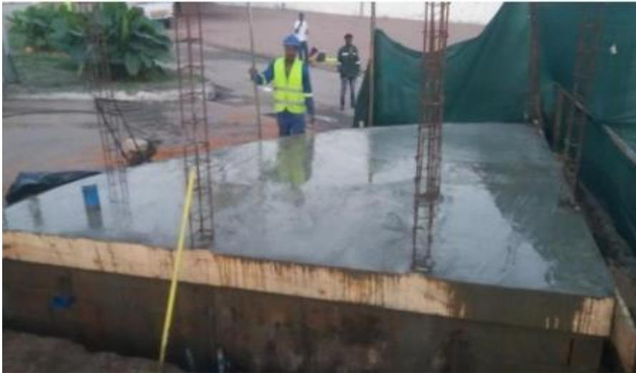
Figura 59. Betonagem da laje de pavimento. (Fonte: Estagiário).
