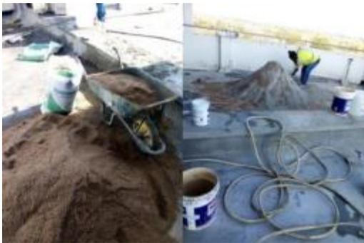
**Figura 33. Medição dos materiais e preparo manual da betonilha. (Fonte: Estagiário).**
