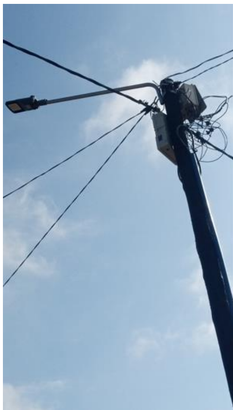
FIGURA7: Apoio com luminária Controlada por uma fotocélula
