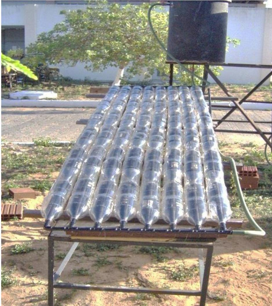
*Figura 23. O Colector solar instalado no sistema para aquecimento de água depois da sua construção*
