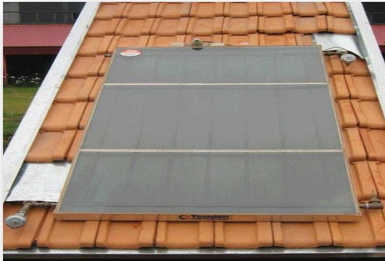
*Figura 5. Colector de placa plana convencional*
