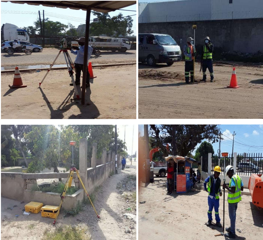
Figura 43: Equipamentos topográficos usados para implantação de cotas topográficas – Fonte: Adaptado pelo autor (2022)
