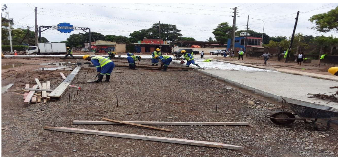
Figura 97: Implantação da laje de betão (km 3+200) – Fonte: Adaptado pelo autor (2023)
