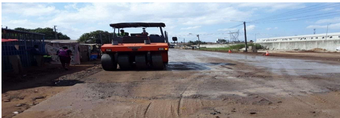
Figura 76: Compactação da plataforma com compactador rolo pneumático (km 5+795) – Fonte: Adaptado pelo autor (2022)
