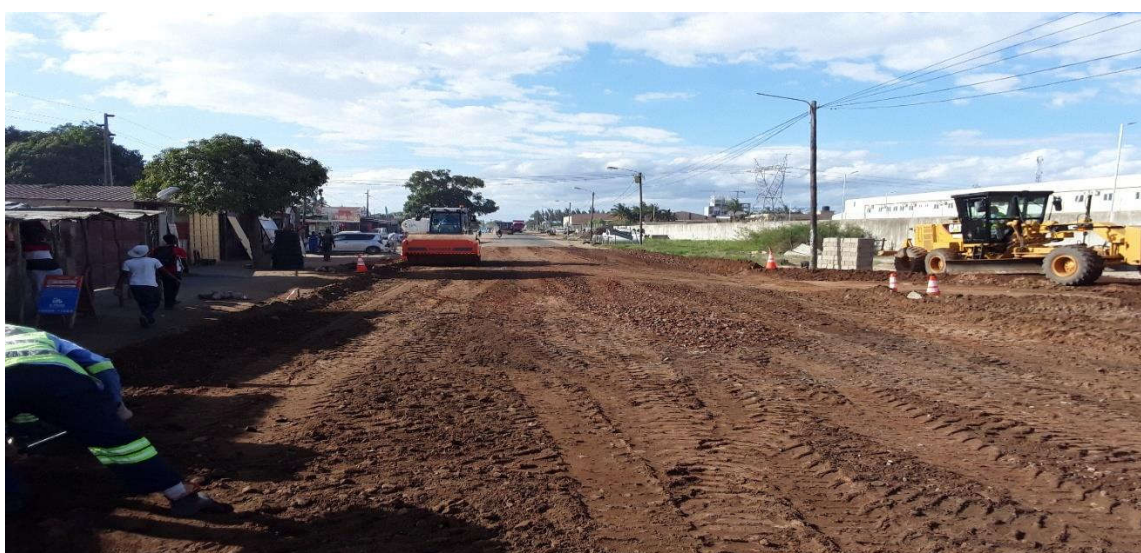
Figura 59: Compactação da camada de sub-base (km 5+795) – Fonte: Adaptado pelo autor (2022)
