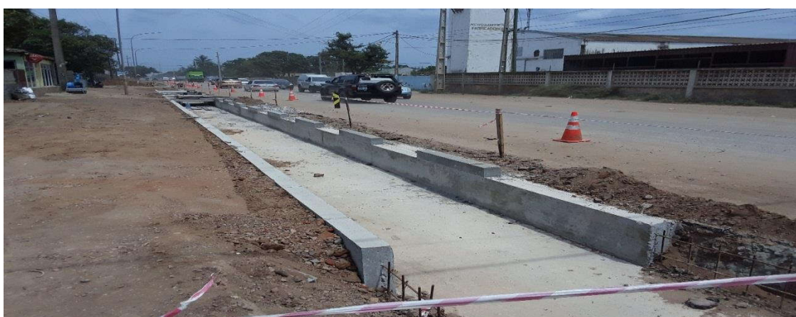
Figura 115: Vala rectangular (km 3+200) – Fonte: Adaptado pelo autor (2022)
