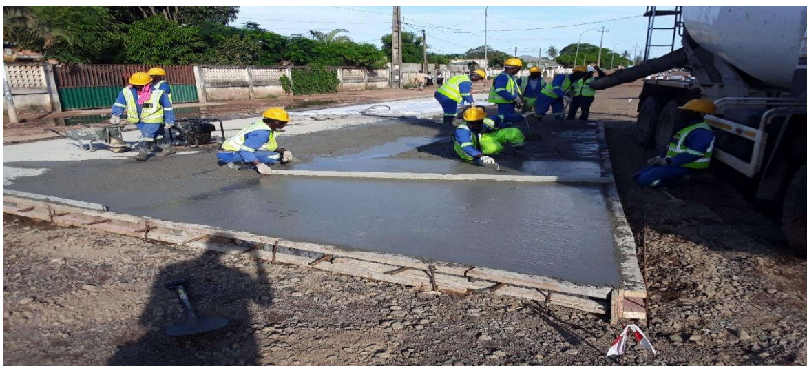
Figura 101: Regularização da laje de betão (km 3+200) – Fonte: Adaptado pelo autor (2023)
