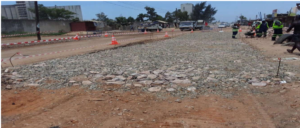
Figura 49: Colocação de material tout-venant para redução de vazios (km 5+795) – Fonte: Adaptado pelo autor (2022)
