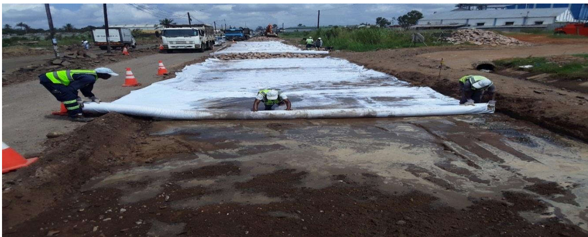
Figura 63: Colocação da segunda camada de manta geotêxtil (km 0+250) – Fonte: Adaptado pelo autor (2022)
