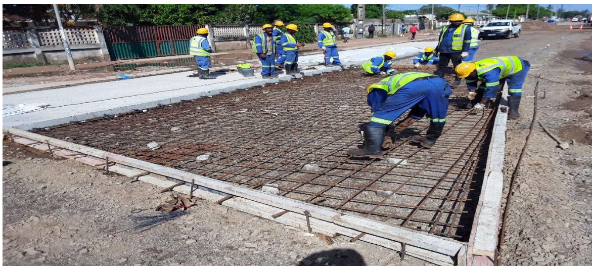
Figura 99: Colocação de armadura (km 3+200) – Fonte: Adaptado pelo autor (2023)
