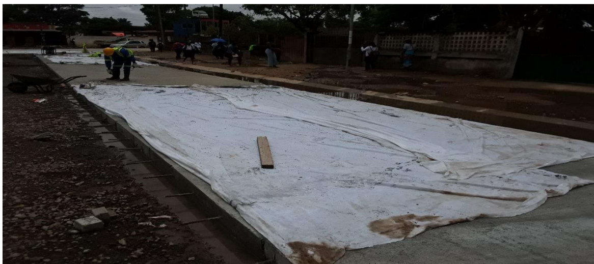
Figura 104: Cura das Lajes de betão (km 3+200) – Fonte: Adaptado pelo autor (2023)
