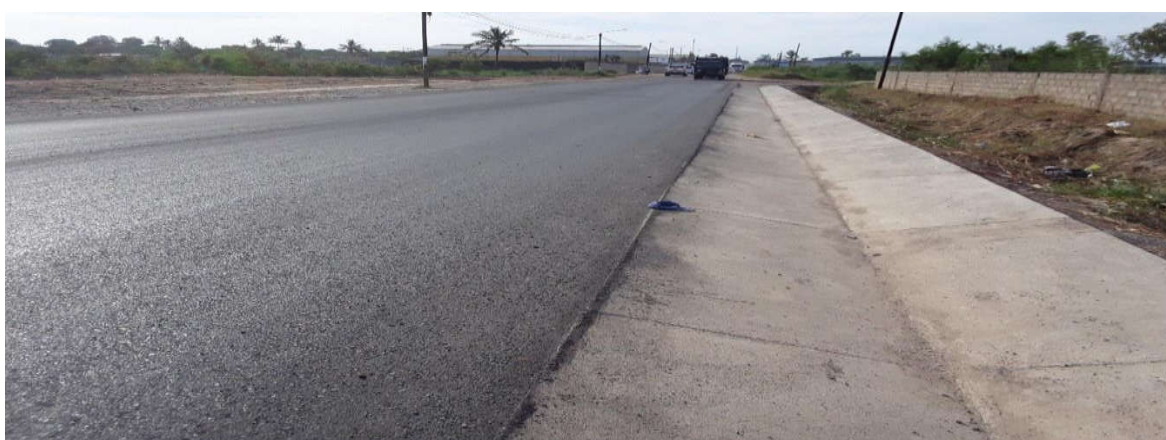
Figura 92: Revestimento do pavimento final (km 0+250) – Fonte: Adaptado pelo autor (2023)
