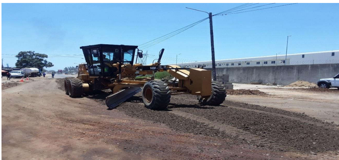
Figura 72: Espalhamento do material estabilizado da camada de base (km 5+795) – Fonte: Adaptado pelo autor (2022)
