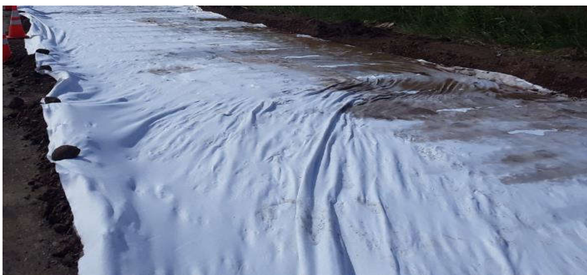
Figura 61: Colocação da primeira camada de manta geotêxtil (km 0+250) – Fonte: Adaptado pelo autor (2022)
