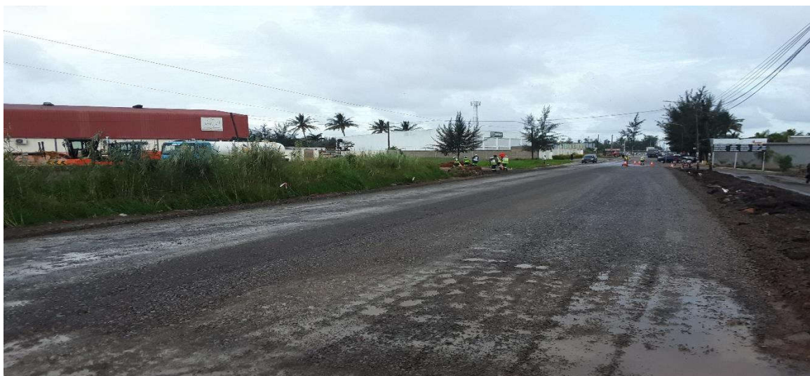
Figura 70: Camada de sub-base finalizada (km 0+250) – Fonte: Adaptado pelo autor (2022)
