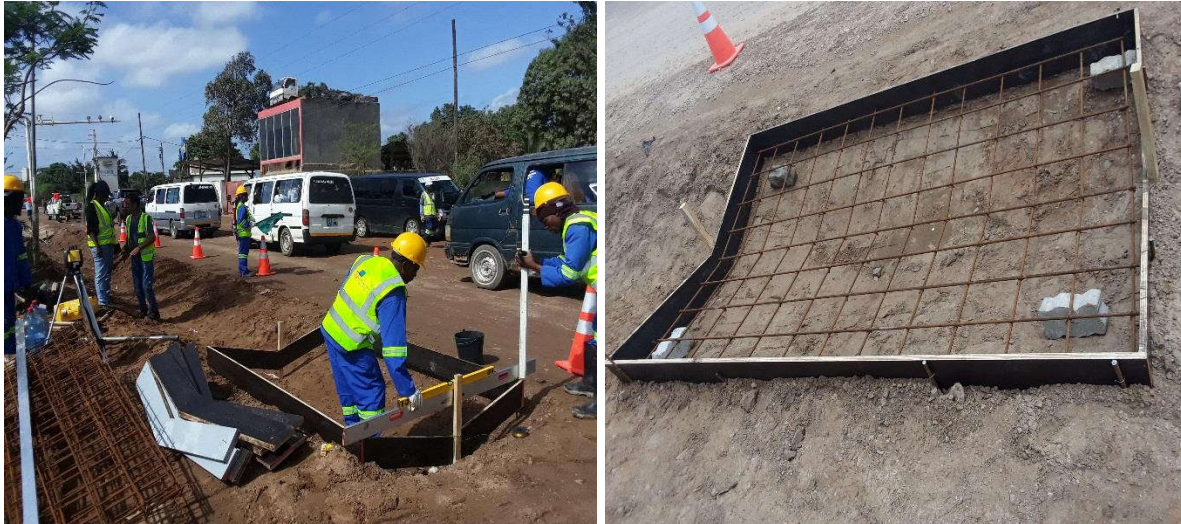
Figura 108: Cofragem e armação da valeta triangular (km 3+200) – Fonte: Adaptado pelo autor (2022)
