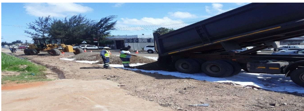
Figura 65: Fornecimento do material tout-venant (km 0+250) – Fonte: Adaptado pelo autor (2022)
