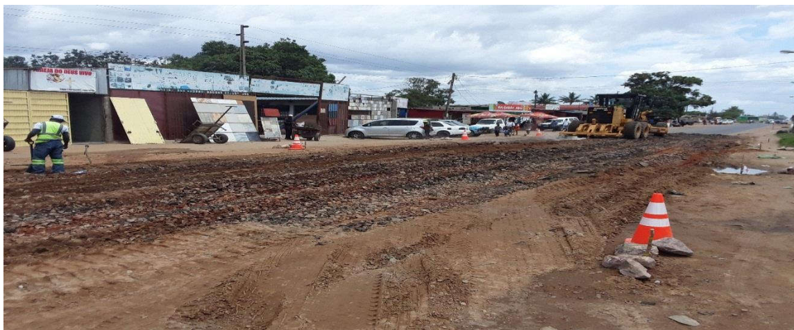
Figura 56: Escarificação do pavimento betuminoso existente (km 5+795) – Fonte: Adaptado pelo autor (2022)
