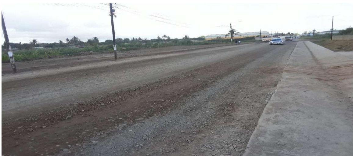
Figura 79: Camada de base finalizada (km 0+250) – Fonte: Adaptado pelo autor (2023)
