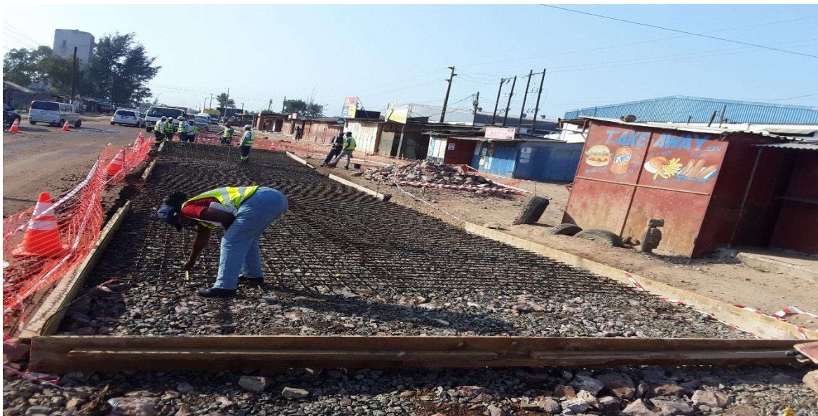
Figura 50: Preparação da cofragem e colocação da malha electrossoldada (km 5+795) – Fonte: Adaptado pelo autor (2022)
