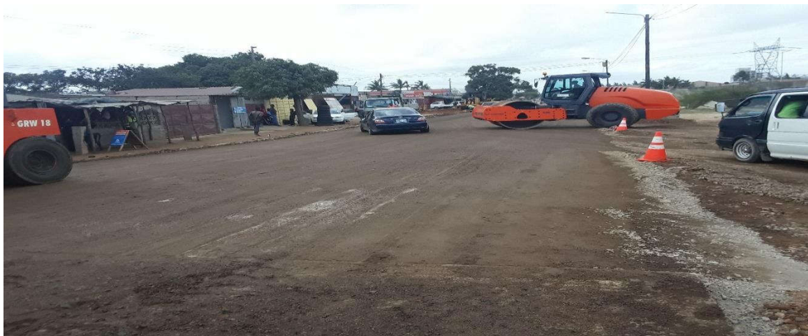
Figura 78: Camada de base finalizada (km 5+795) – Fonte: Adaptado pelo autor (2022)
