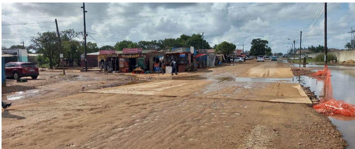
Figura 55: Passagem molhada concluída (km 5+795) – Fonte: Adaptado pelo autor (2022)
