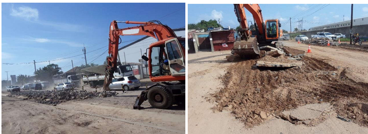
Figura 46: Demolição da estrutura existente (km 3+200 e km 5+795) – Fonte: Adaptado pelo autor (2023)
