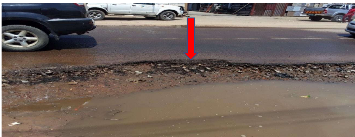
Figura 18: Patologia tipo falha na aresta (Estrada R807: Coca-Cola/ Matola-Gare – Socimol/MEREC) – Fonte: Adaptado pelo autor (2022)
