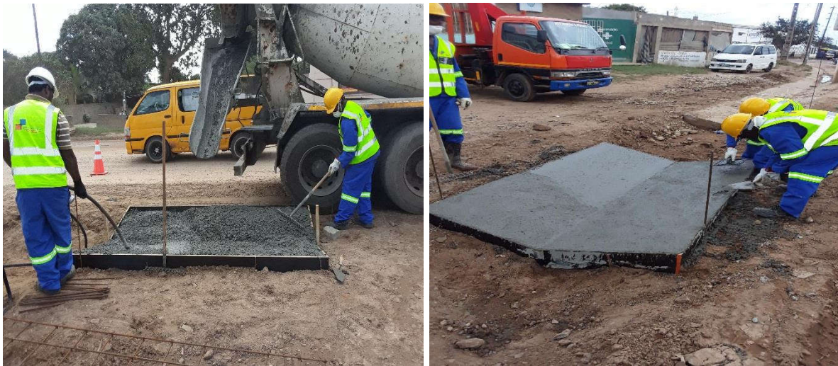
Figura 109: Betonagem, regularização e talochagem da valeta triangular (km 3+200) – Fonte: Adaptado pelo autor (2022)
