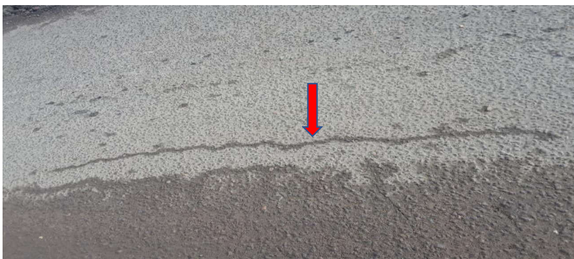
Figura 23: Patologia tipo fissura longitudinal (Estrada R807: Coca-Cola/ Matola-Gare – Coca-Cola) – Fonte: Adaptado pelo autor (2022)
