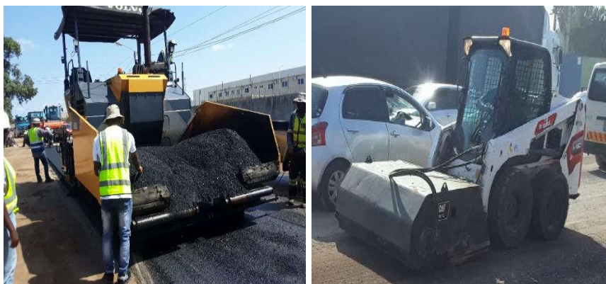
Figura 40: Pavimentadora e Bobcat amplificada com uma vassoura mecânica – Fonte: Adaptado pelo autor (2022)
