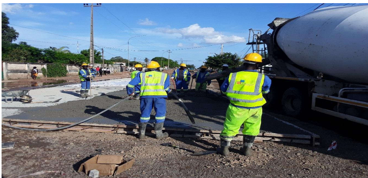
Figura 100: Colocação e vibração do betão (km 3+200) – Fonte: Adaptado pelo autor (2023)
