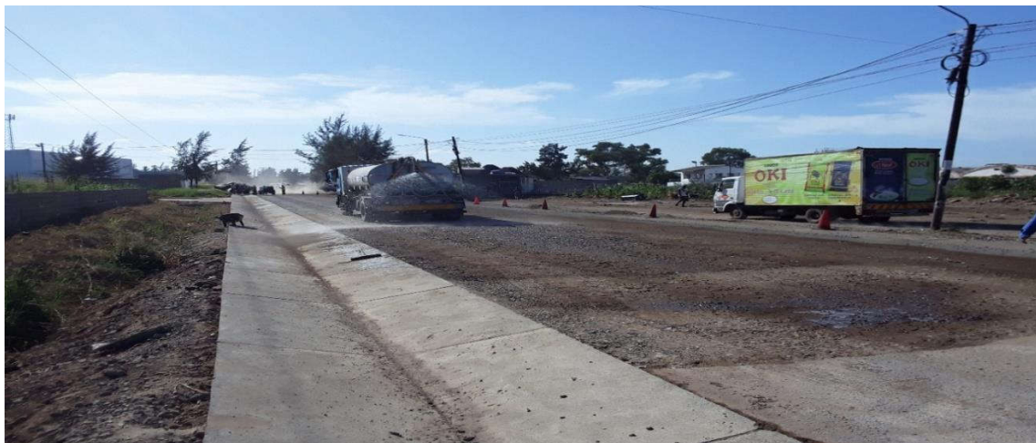
Figura 85: Pulverização da superfície com água (km 0+250) – Fonte: Adaptado pelo autor (2023)
