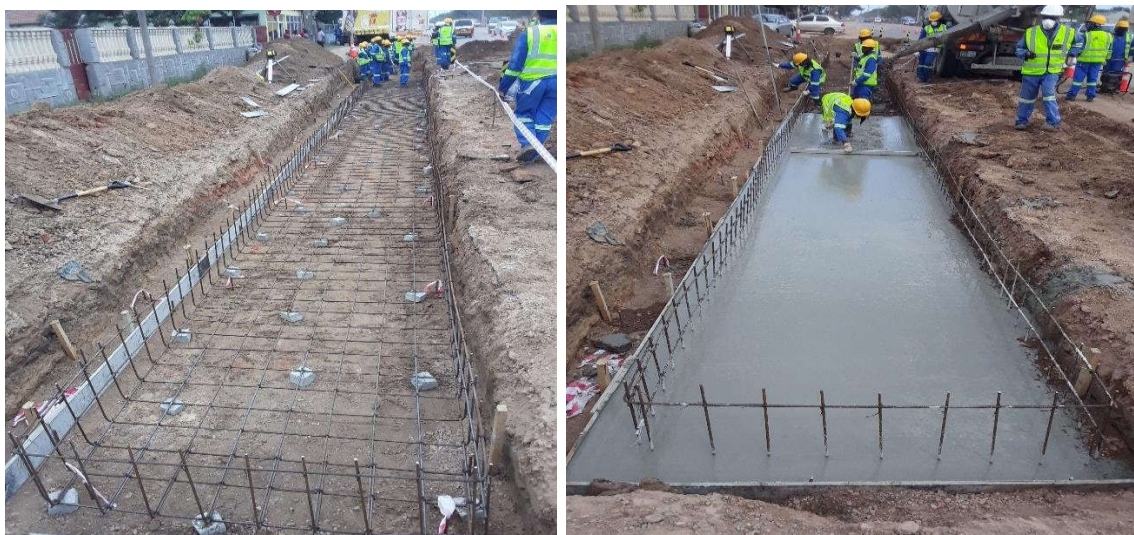
Figura 111: Armação, betonagem e alisamento da laje de fundo da vala rectangular (km 3+200) – Fonte: Adaptado pelo autor (2022)
