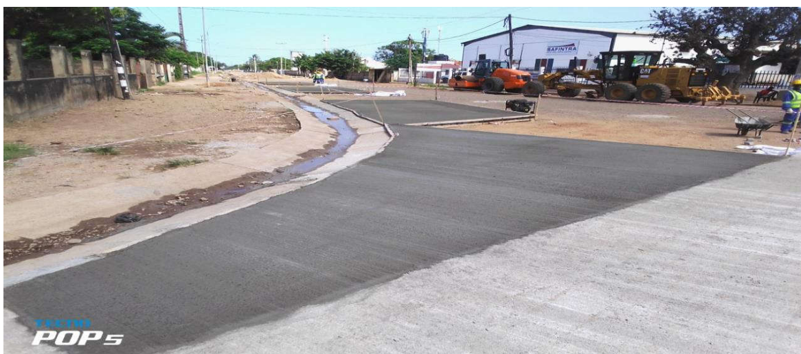
Figura 103: Laje de betão finalizada (km 3+200) – Fonte: Adaptado pelo autor (2023)
