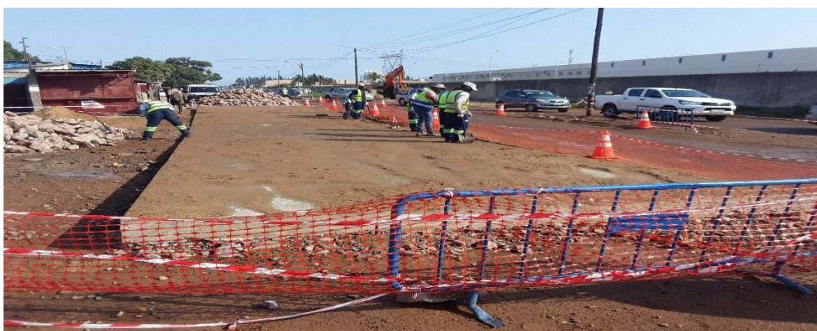
Figura 54: Colocação de areia grossa para manter a umidade na cura do betão (km 5+795) – Fonte: Adaptado pelo autor (2022)
