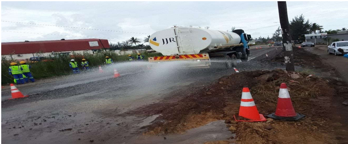
Figura 67: Rega da plataforma para tarefas de compactação (km 0+250) – Fonte: Adaptado pelo autor (2022)
