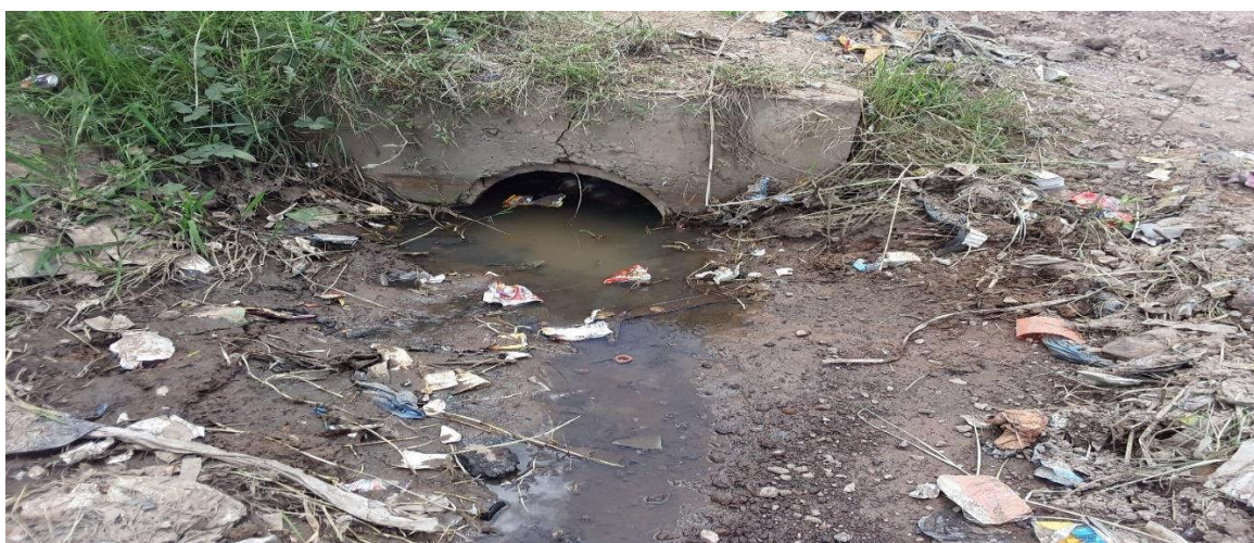
Figura 32: Situação da passagem de água existente (Estrada R807: Coca-Cola/ Matola-Gare – Coca-Cola) – Fonte: Adaptado pelo autor (2022)
