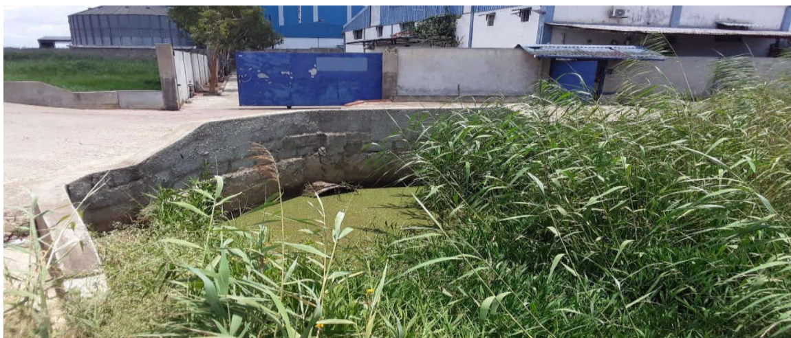
Figura 34: Situação da valeta existente depois das chuvas (Estrada R807: Coca-Cola/ Matola-Gare – Coca-Cola) – Fonte: Adaptado pelo autor (2022)
