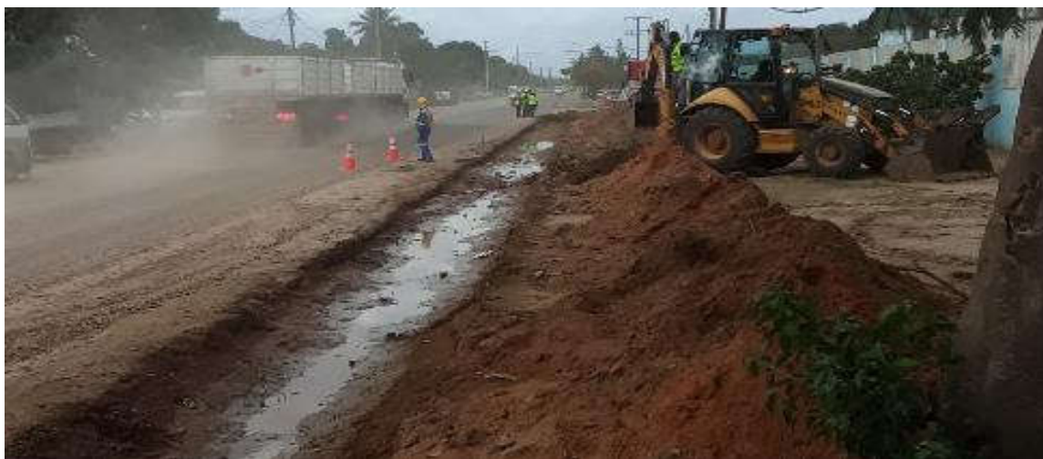
Figura 105: Escavação da fundação da valeta triangular (km 3+200) – Fonte: Adaptado pelo autor (2022)
