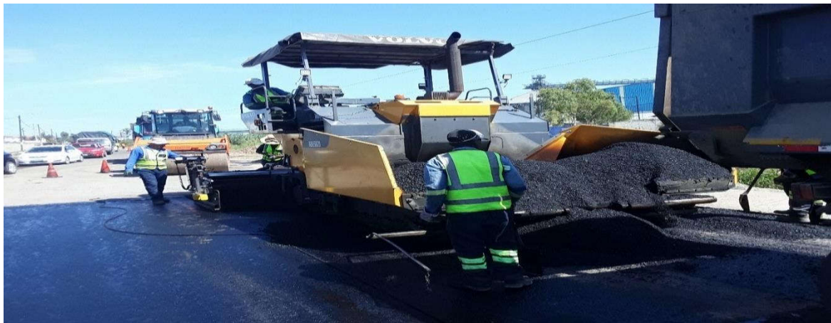
Figura 88: Colocação da mistura betuminoso (km 0+250) – Fonte: Adaptado pelo autor (2023)
