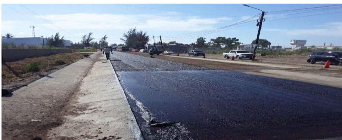
Figura 87: Impregnação betuminosa (km 0+250) – Fonte: Adaptado pelo autor (2023)
