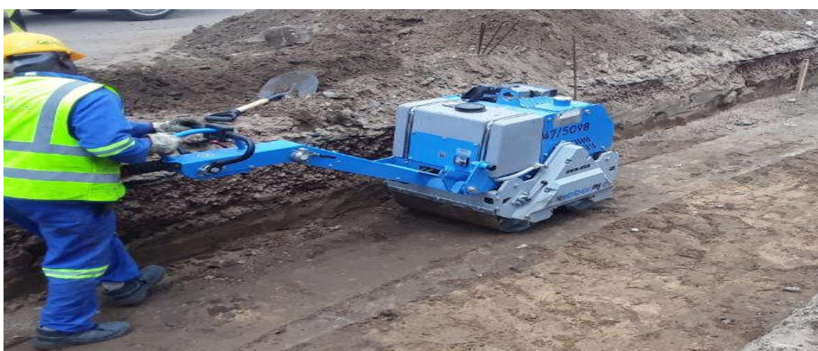
Figura 107: Compactação da fundação da vala rectangular (km 3+200) – Fonte: Adaptado pelo autor (2022)
