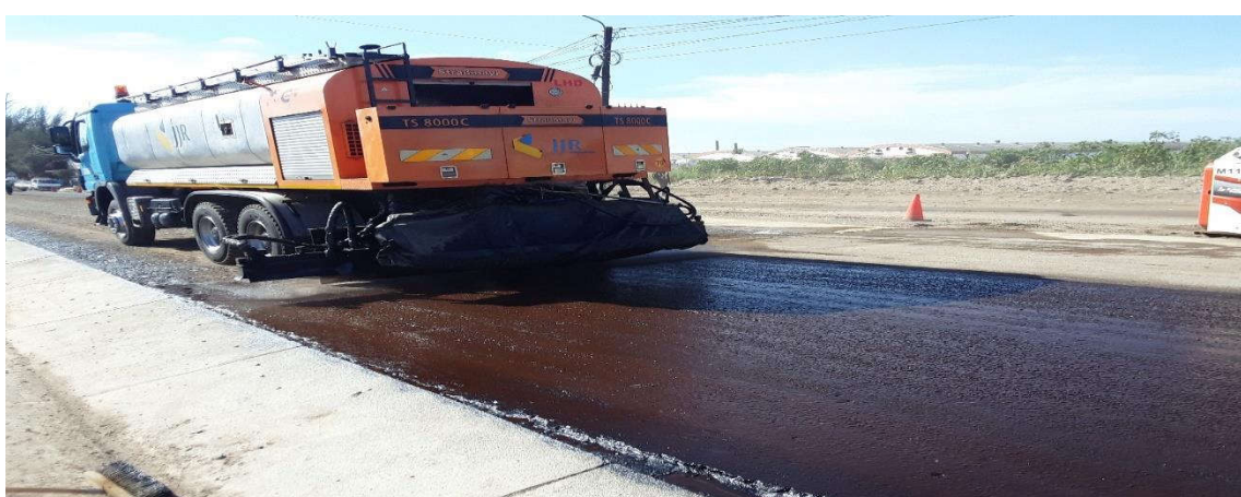
Figura 86: Colocação da impregnação betuminosa (km 0+250) – Fonte: Adaptado pelo autor (2023)
