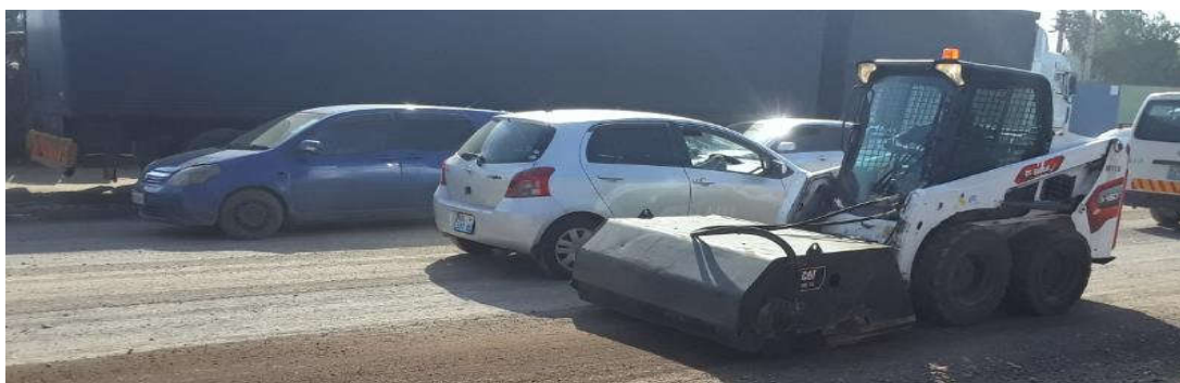
Figura 82: Limpeza da plataforma com vassoura mecânica (km 0+250)– Fonte: Adaptado pelo autor (2023)
