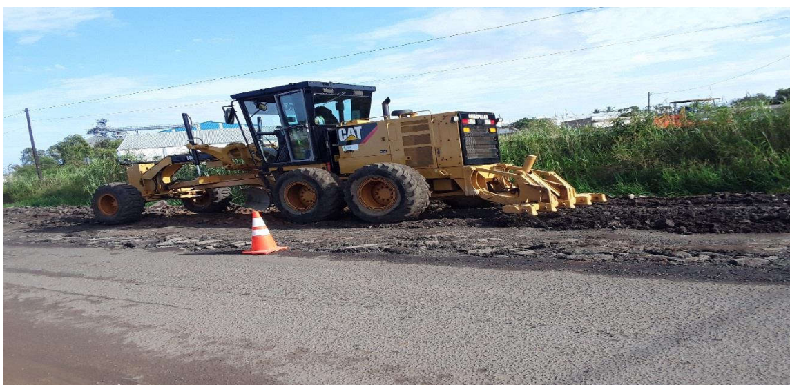
Figura 57: Escarificação do pavimento betuminoso existente (km 0+250) – Fonte: Adaptado pelo autor (2022)
