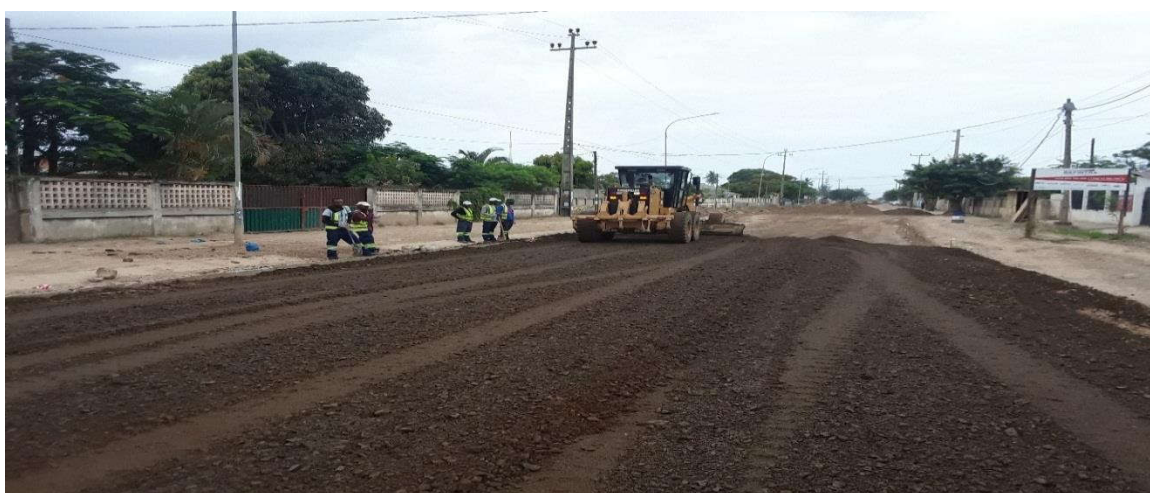
Figura 96: Espalhamento do material para a sub-base (km 3+200) – Fonte: Adaptado pelo autor (2023)
