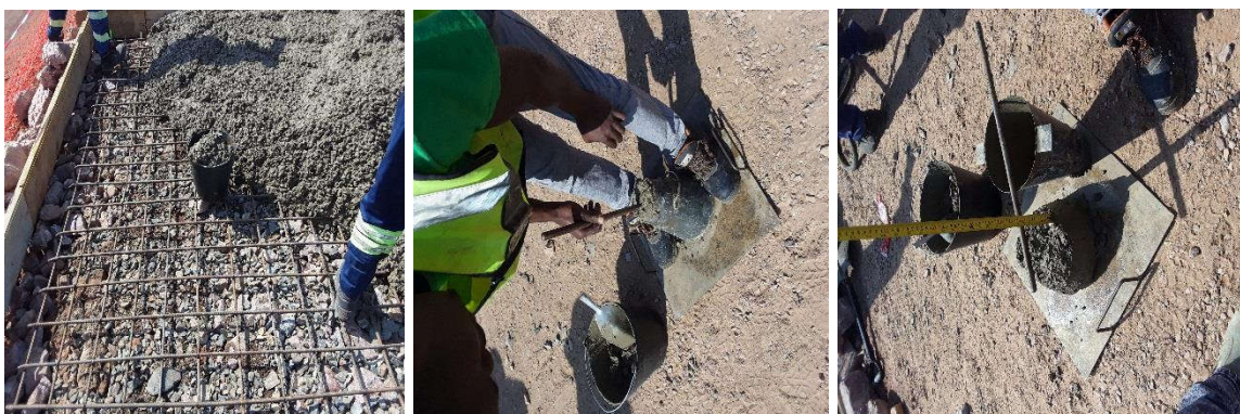
Figura 51: Slump test do betão recém chegado (km 5+795) – Fonte: Adaptado pelo autor (2022)
