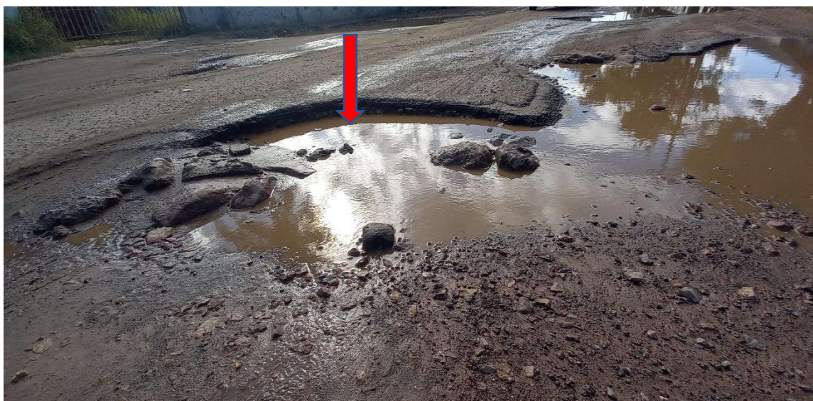
Figura 15: Patologia tipo panela ou buraco (Estrada R807: Coca-Cola/ Matola-Gare – Mafurreira) – Fonte: Adaptado pelo autor (2022)
