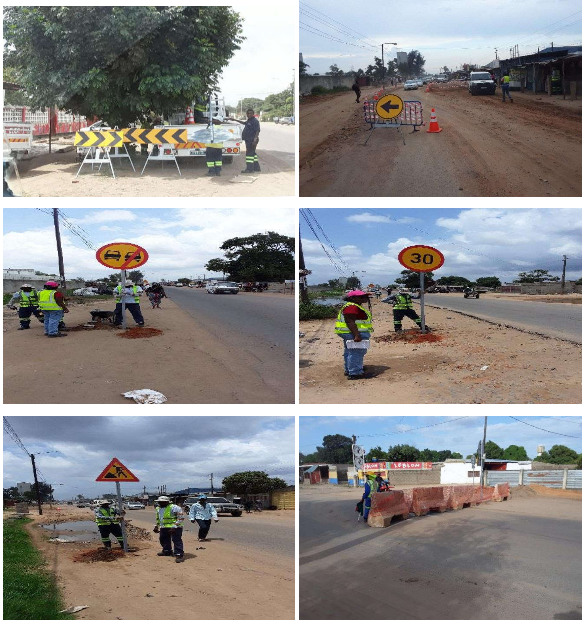
Figura 41: Sinalização temporária para a gestão do tráfego – Fonte: Adaptado pelo autor (2023)
