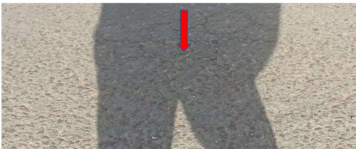
Figura 20: Patologia tipo pele de crocodilo (Estrada R807: Coca-Cola/ Matola-Gare – Mafurreira) – Fonte: Adaptado pelo autor (2022)
