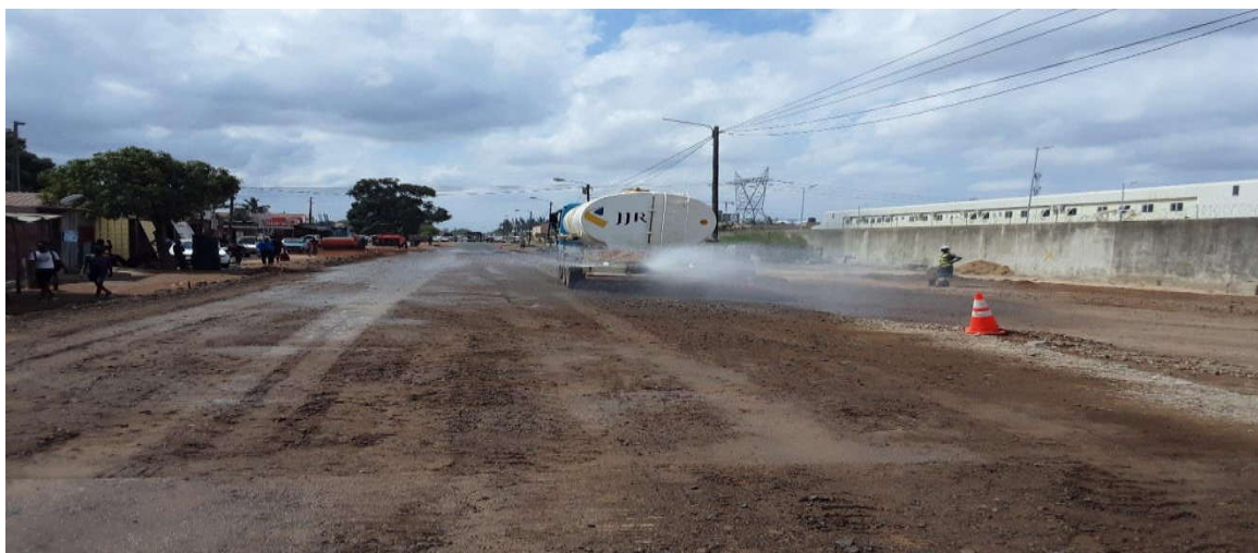
Figura 73: Rega da plataforma para manter a humidade do material (km 5+795) – Fonte: Adaptado pelo autor (2022)
