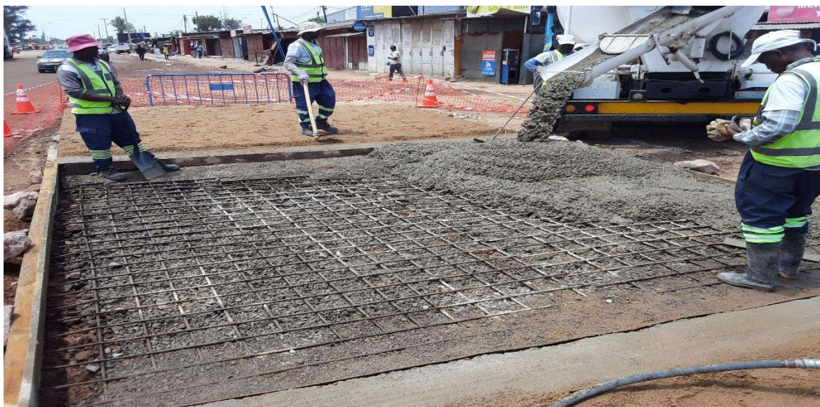
Figura 52: Colocação, espalhamento e adensamento do betão (km 5+795) – Fonte: Adaptado pelo autor (2022)
