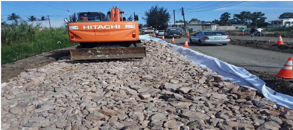
Figura 62: Colocação das pedras rachão em espessuras de 20 cm (km 0+250) – Fonte: Adaptado pelo autor (2022)
