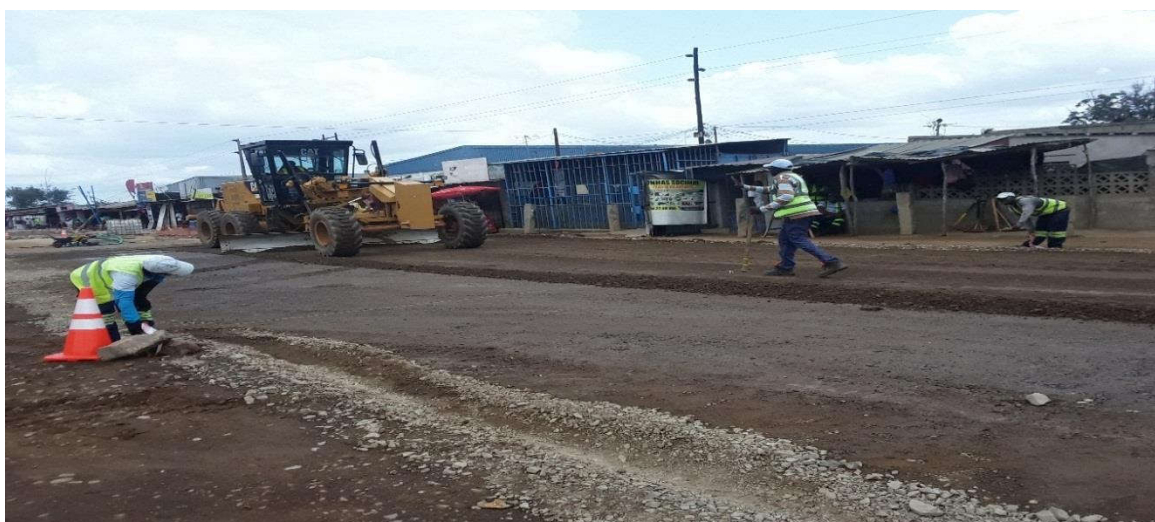
Figura 75: Verificação das cotas e cortes do material excedente (km 5+795) – Fonte: Adaptado pelo autor (2022)
