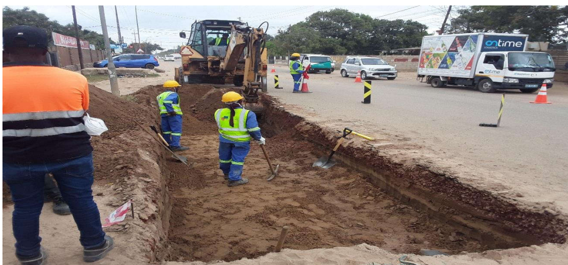
Figura 106: Escavação da fundação da vala rectangular (km 3+200) – Fonte: Adaptado pelo autor (2022)
