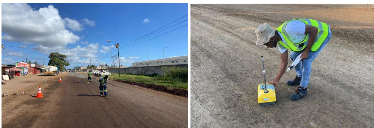
Figura 77: Ensaio de compactação com o TROXLER (km 5+795) – Fonte: Adaptado pelo autor (2022)
