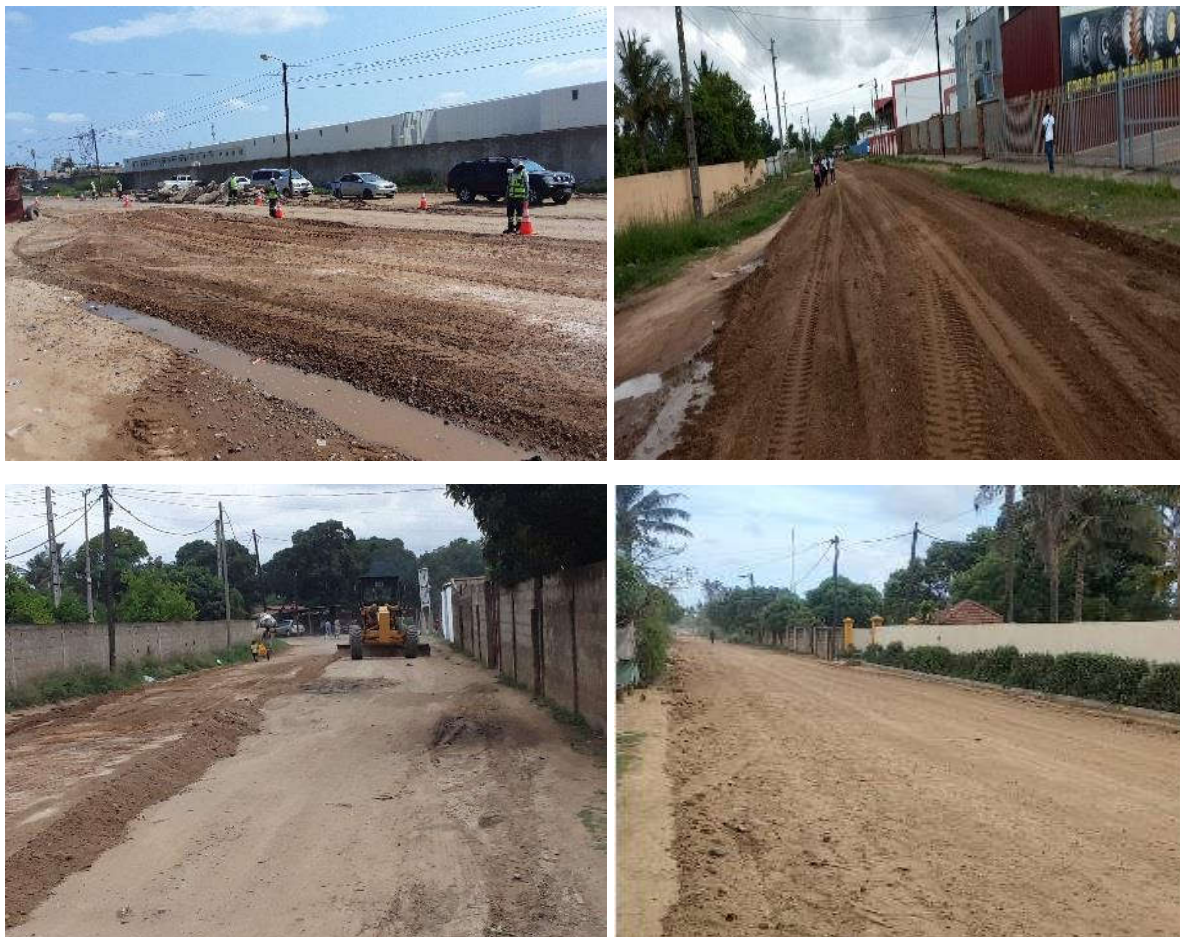
Figura 42: Construção dos desvios temporários para assegurar a circulação do tráfego – Fonte: Adaptado pelo autor (2022)
