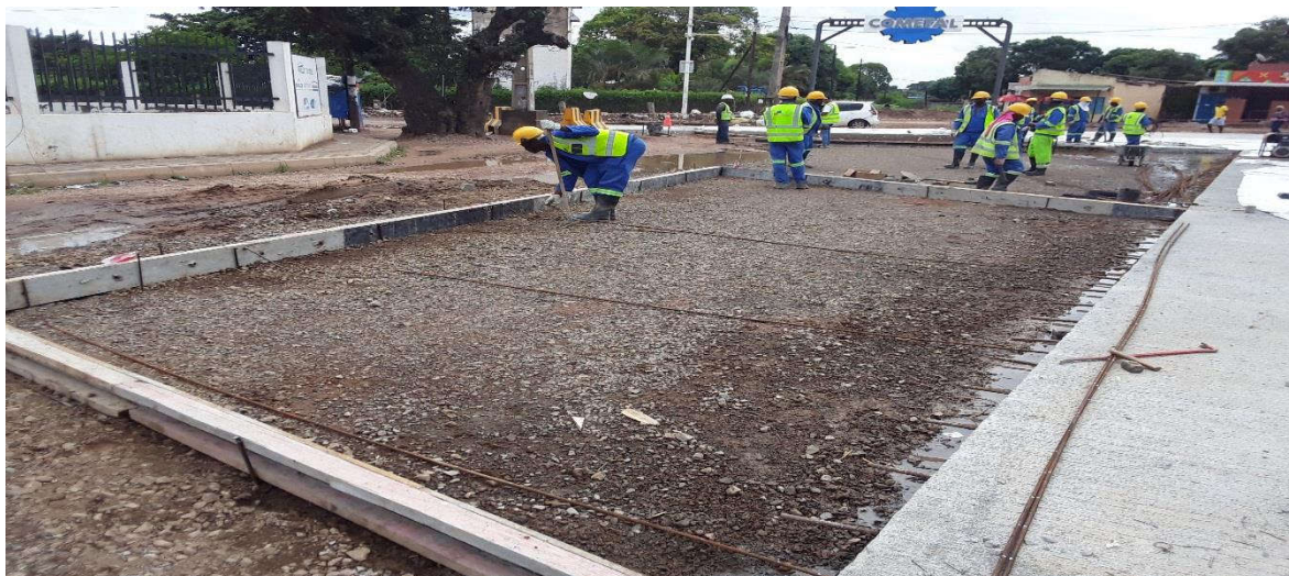
Figura 98: Cofragem da laje (km 3+200) – Fonte: Adaptado pelo autor (2023)
