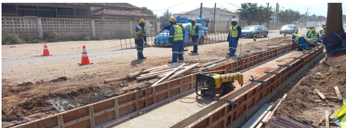
Figura 113: Cofragem dos muretes da vala rectangular (km 3+200) – Fonte: Adaptado pelo autor (2022)
