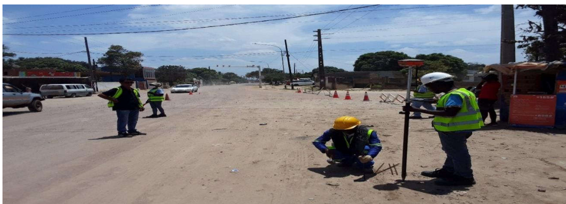
Figura 94: Implantação de cotas topográficas (km 3+200) – Fonte: Adaptado pelo autor (2023)
