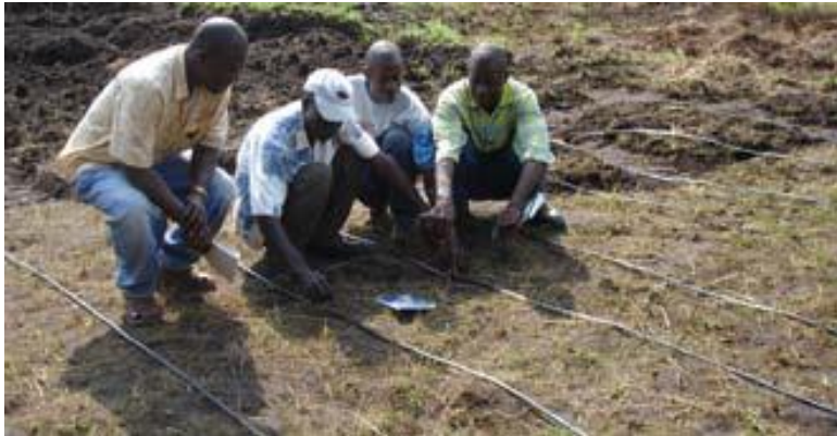
Figura 11: Instalação de linhas
