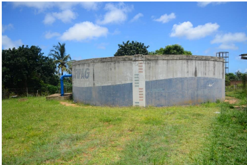
Figura 10- Reservatório de Patrice Lumumba
