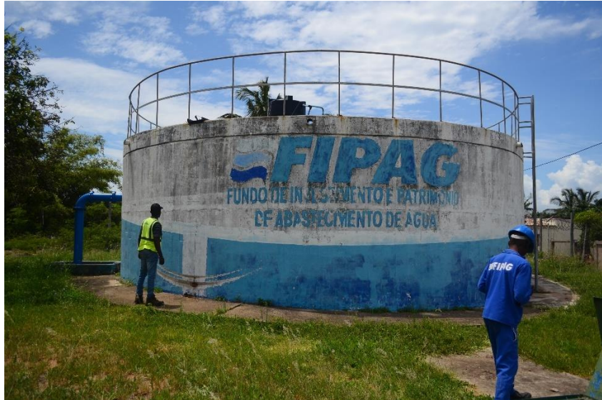
Figura 11- Reservatório do Bairro 13
