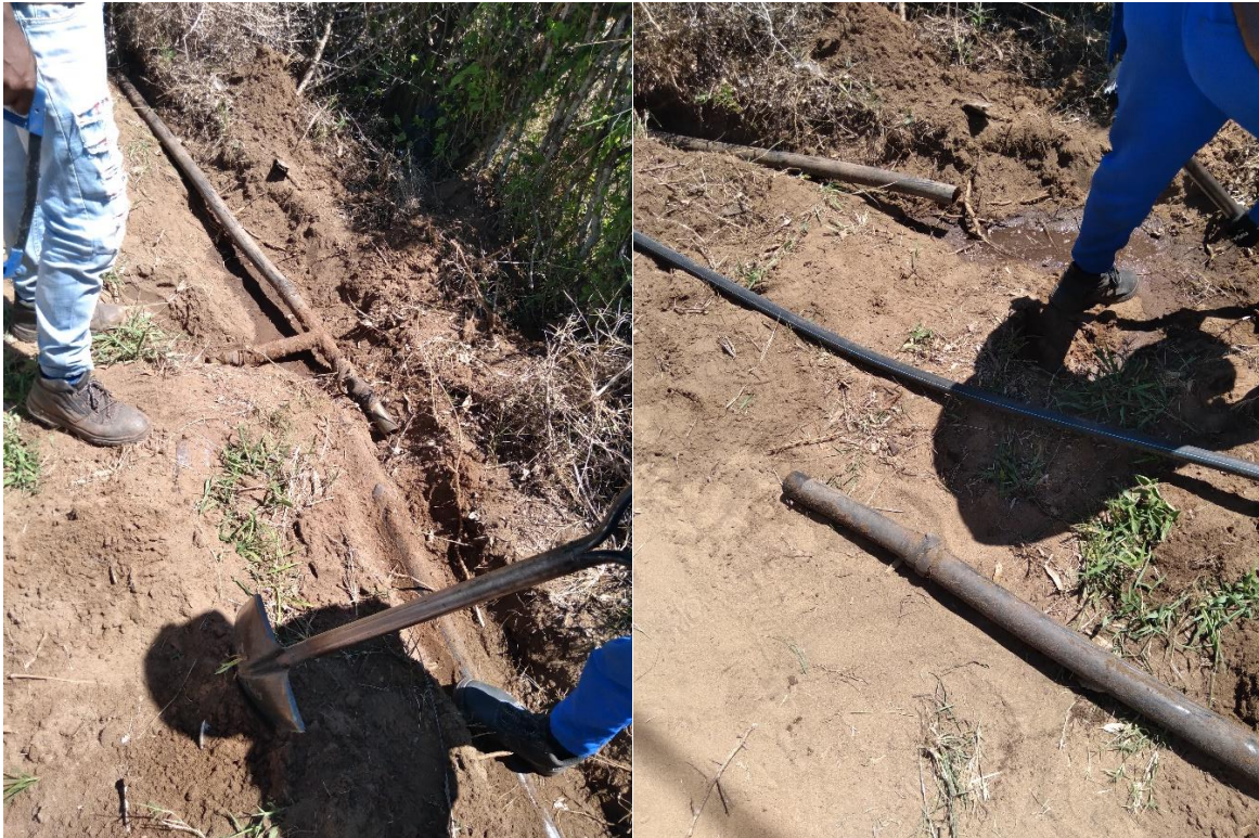
Figura 16- Reparação de fuga de água em rede de distribuição
