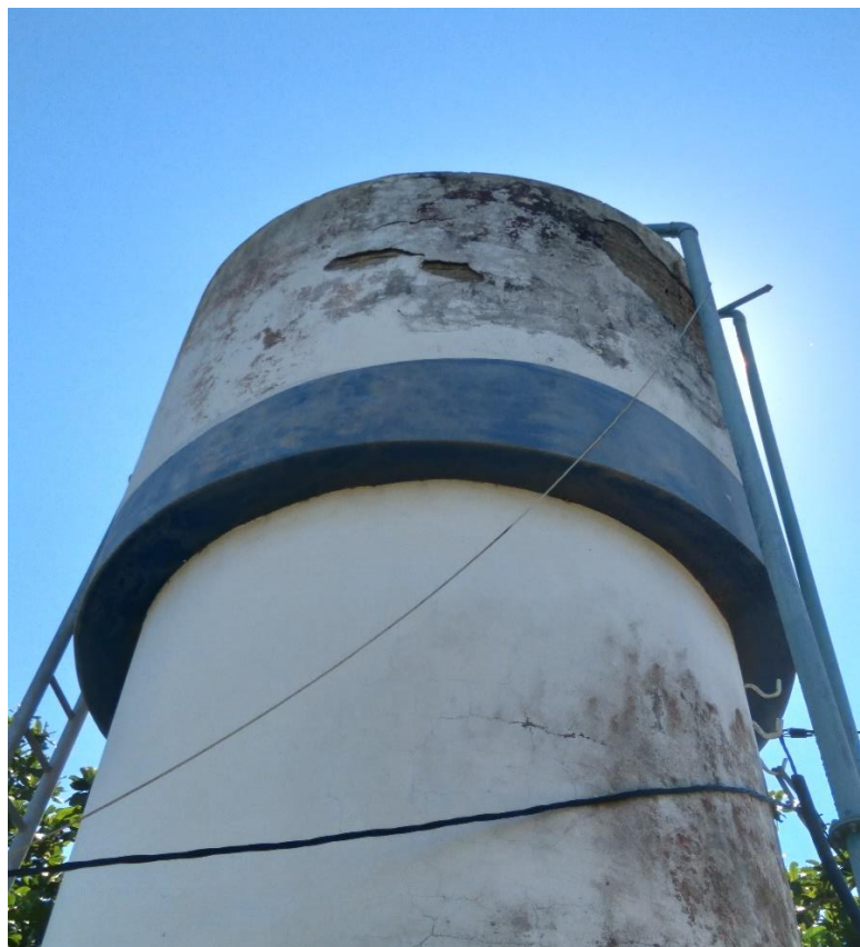
Figura 13- Reservatório de Chicumbane
