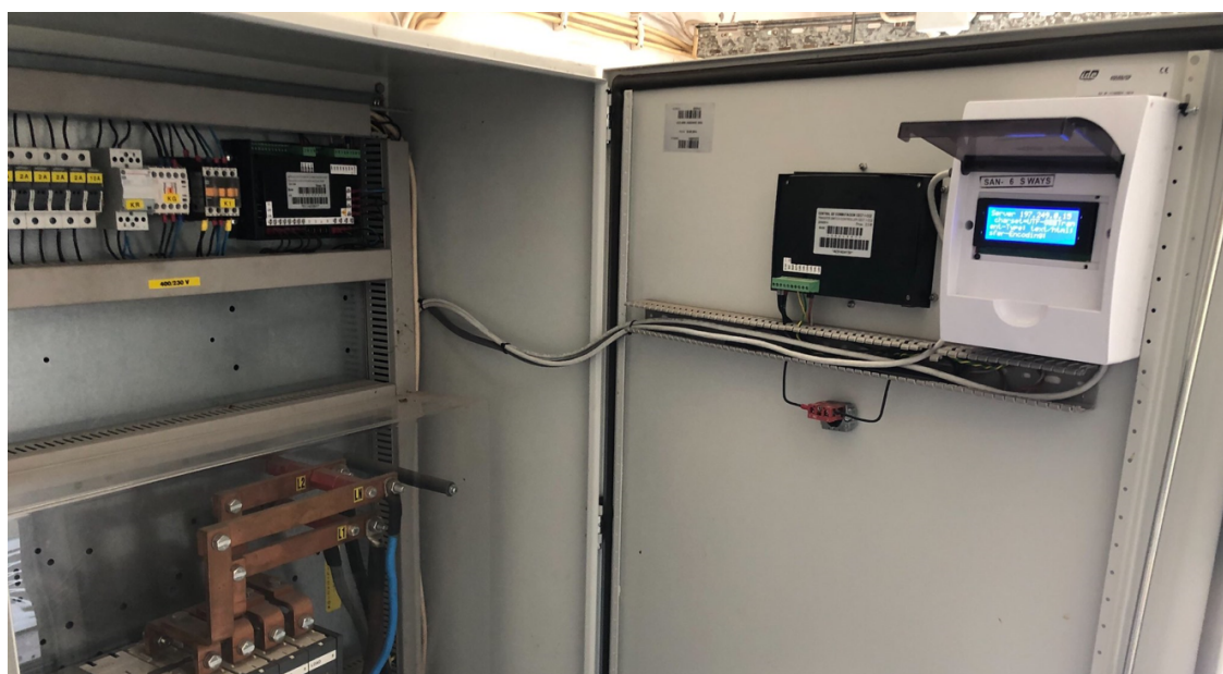
Figura 5.1: - Conexão do hardware de coleta ao gerador via CAN Bus . [Autor, 2022]
