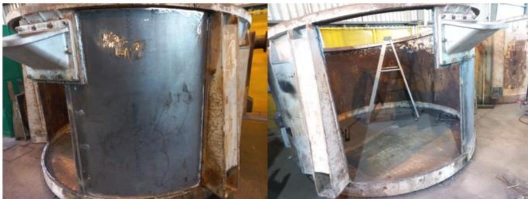
*Figura 4. 9: Processo de substituição da chapa frontal*
