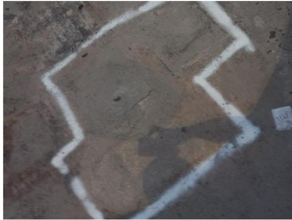
*Figura 4. 4: Marcação para reparação localizada*
