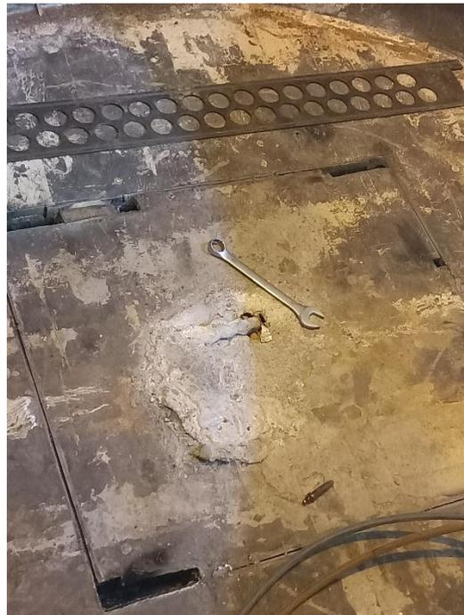
*Figura 4. 5: Corte da chapa na área afectada*
