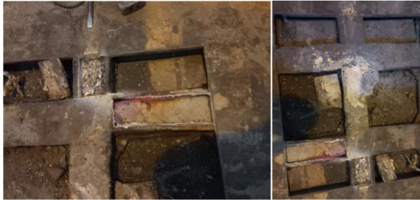
*Figura 4. 6: Presença de alumínio por baixo da chapa, danificando o perfil*
