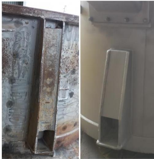
*Figura 3. 1: Gusset deformado ( à esquerda) e Gusset não deformado (à direita)*
