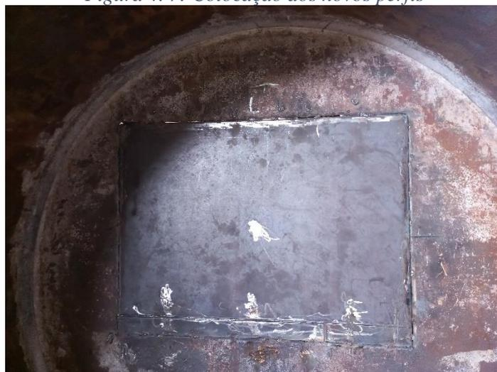
*Figura 4. 8: Colocação da nova chapa*
