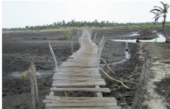
**Figura 12:** Ponte que facilita a ligação parcialmente degradada
