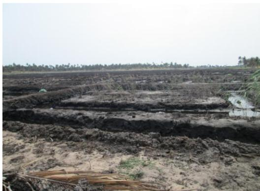
**Figura 13:** Diques construídos nos limites de terra húmida para evitar/reduzir o galgamento de águas salinas.
