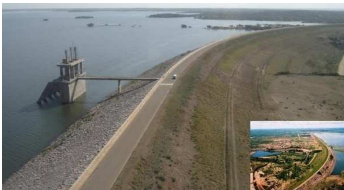
Figura 7: Barragem de Massingir
