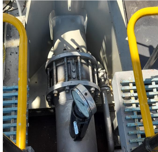
Figura 3.12: Válvula de não retorno (à esquerda), local onde está localizado a válvula de não retorno no Cais P3 (à direita).
