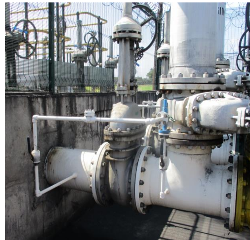
Figura 3.13: Válvulas de alívio de pressão no Cais P3 (à esquerda) e nos manifolds (à direita).
