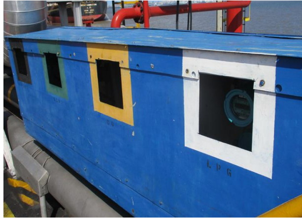
Figura 3.8: Fluxómetros ultrassónicos.
