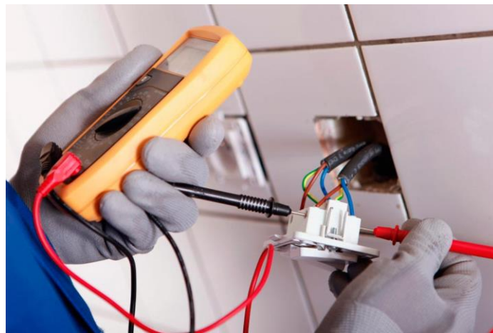
Figura 13 Falta de tensão eléctrica
