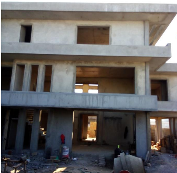
Figura 15 Edifício do cliente em processo de instalação eléctrica Fonte: Autor
