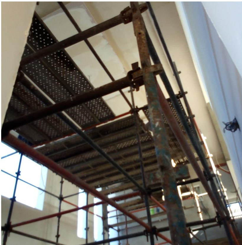
Figura 22 Adaime usado para fazer manutenção instalação no top do edificio
