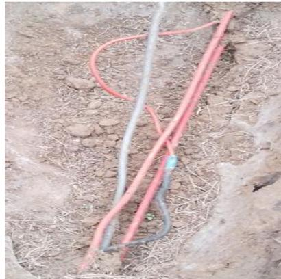
Figura11: Cabo de conexão dos ânodos
