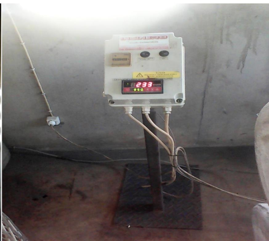
Figura 3.4.: Leitor da temperatura dos resíduos incinerados
