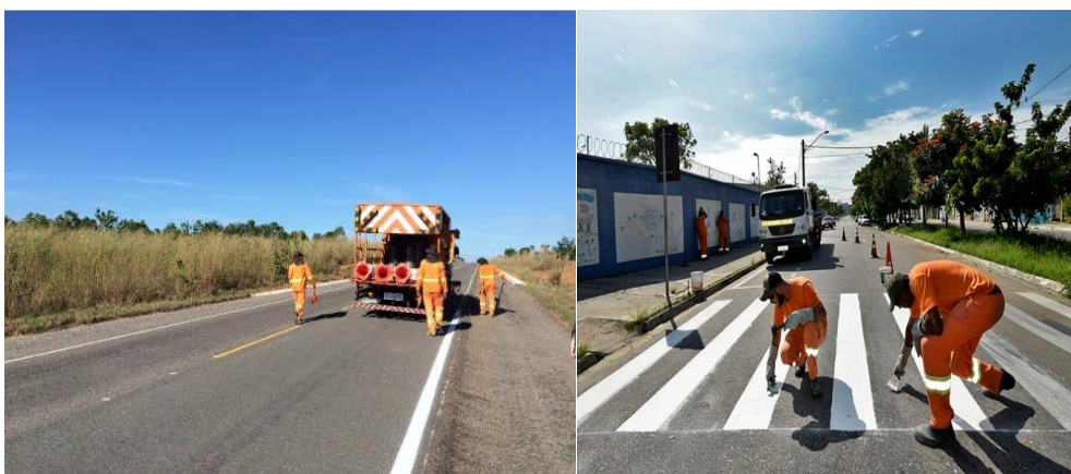
Sinalização Horizontal com recurso a Equipamento Mecanizada
