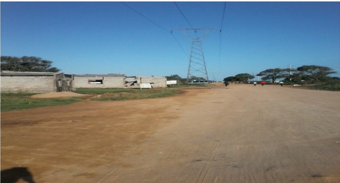
Figura 8: Aglomeração das casas sob redes de alta tensão no Q.nº5A
