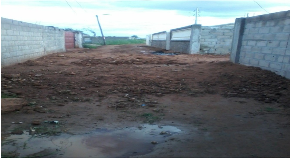
Figura 9: Amontoamento de areia nos quintais e entradas de residências
