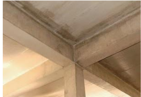
Figura 8. Exemplo de uma laje vigada.
