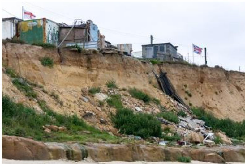
Figura 4.1- Solos sujeitos a erosão
