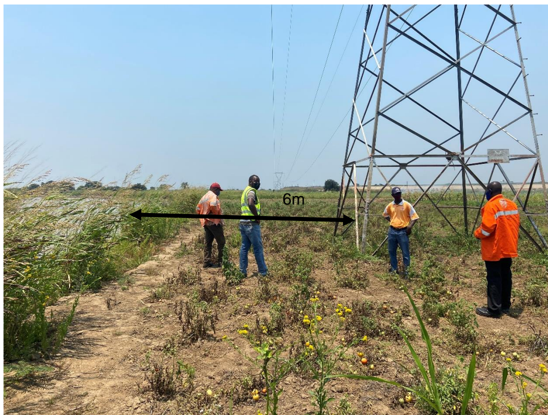
Figura 4.21 – Torre 353 à 6.0 m de distância da margem do rio
