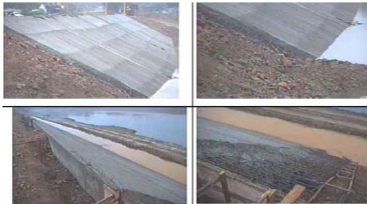
Figura 4.8- Painéis de betão armado
