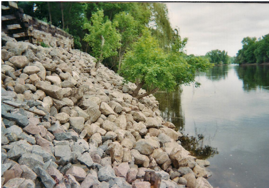
Figura 4.2- Protecção de margens com enrocamento
