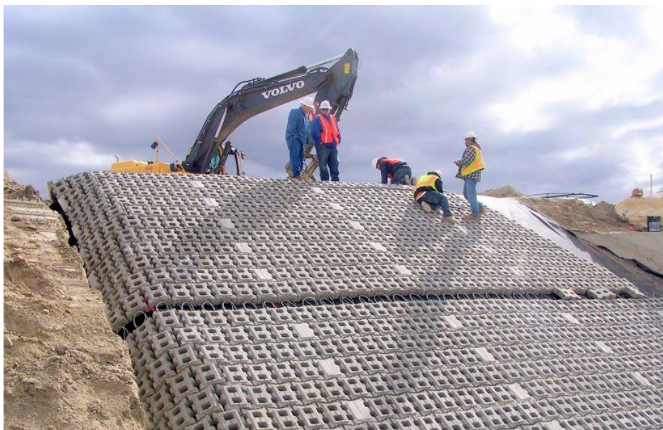
Figura 4.4- Colchão formado por peças articuladas de betão.
