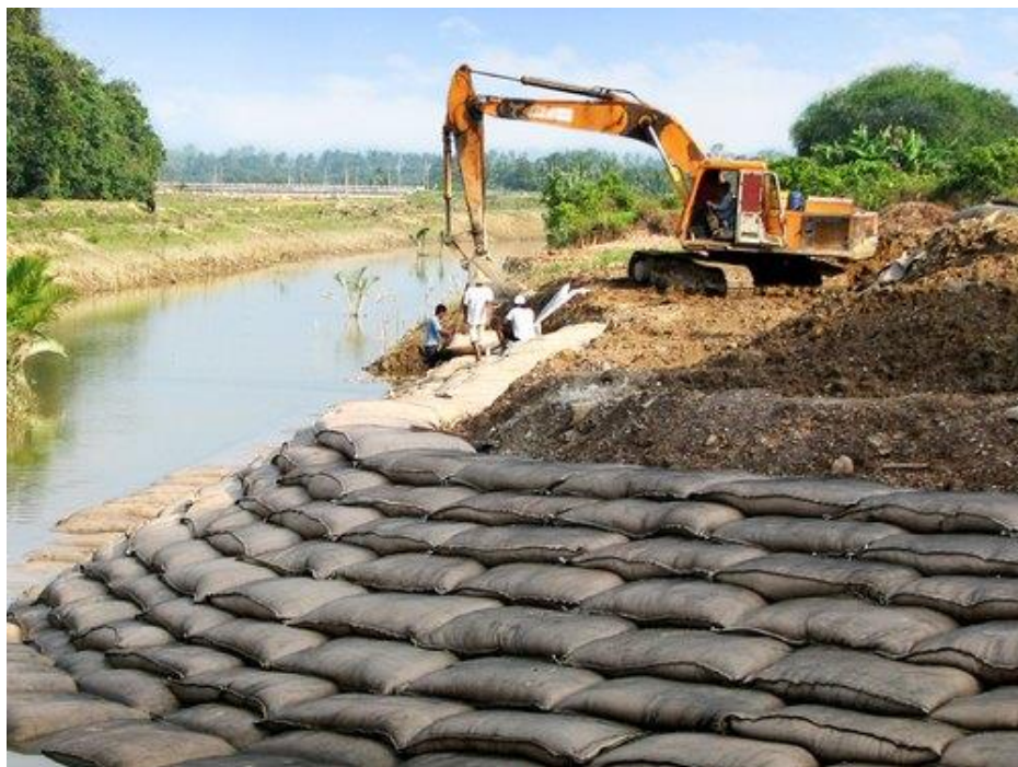
Figura 4.3- Protecção de margens com enrocamento sintético
