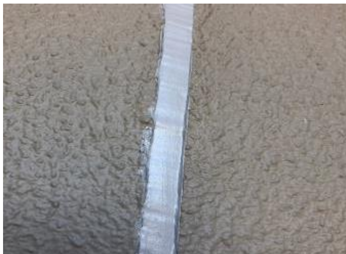
Figura 39. Material de enchimento da junta.
