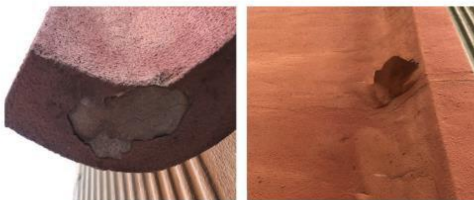
Figura 16. Descasque da pintura em elemento estético.
