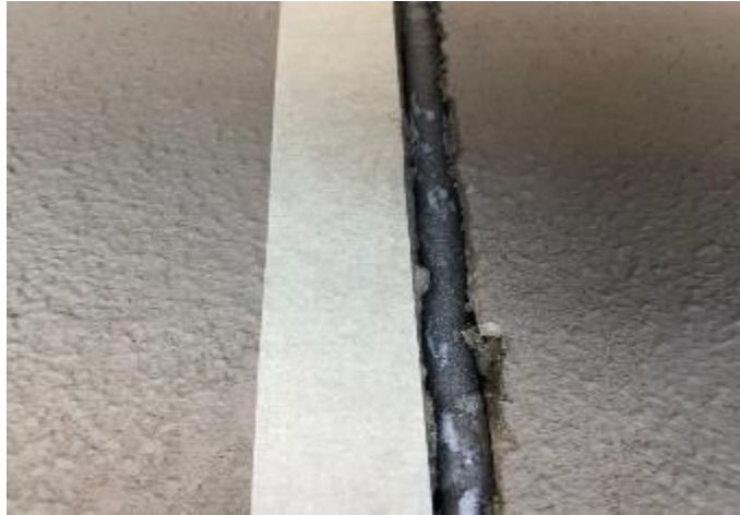
Figura 38. Cordão da junta de dilatação.
