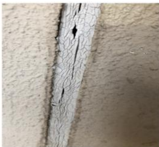
Figura 4. Juntas de dilatação.
