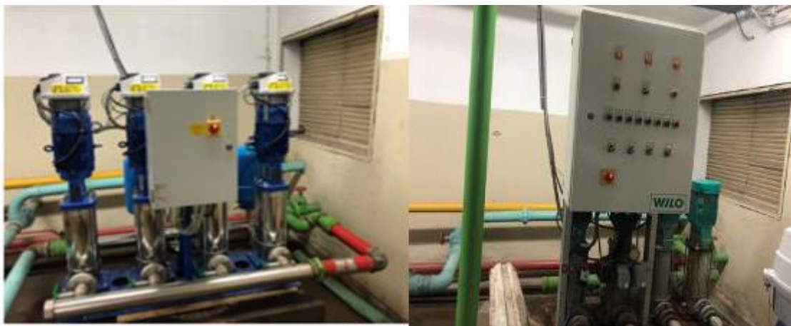
Figura 43. Substituição do 1º grupo de bombagem.
