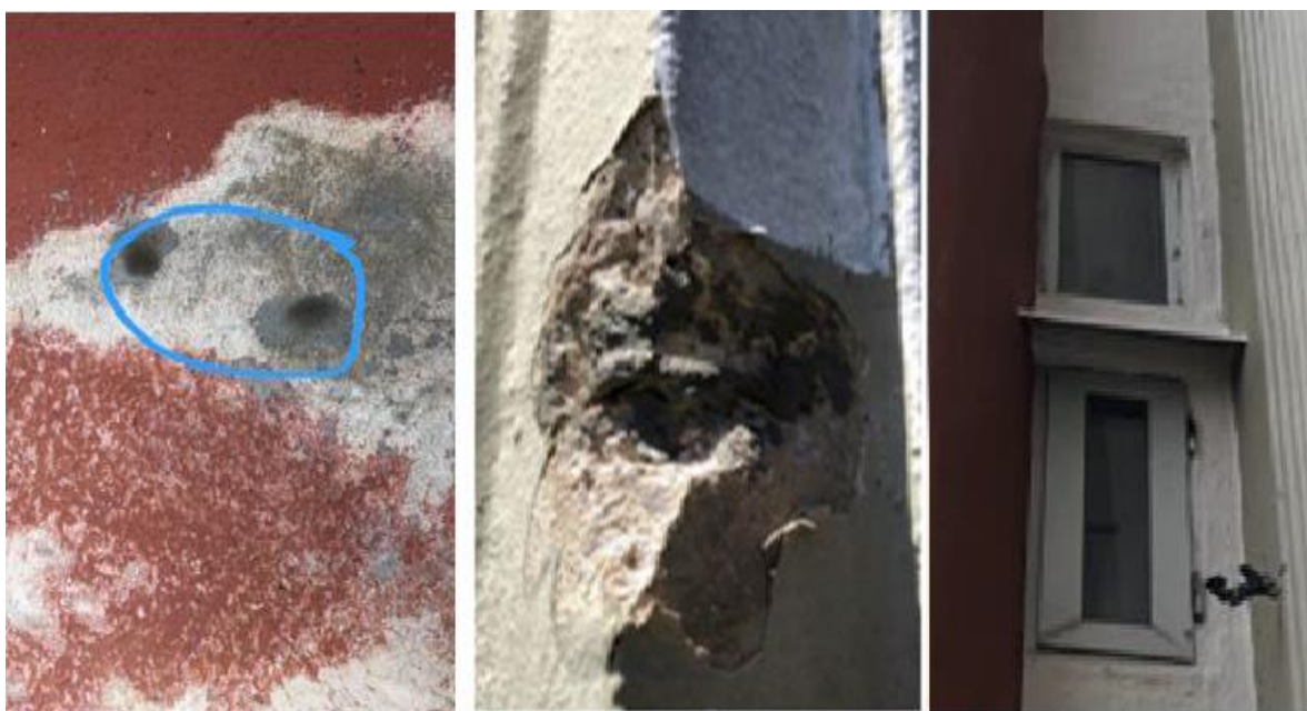
Figura 31. Nivelamento das superfícies, Reparação local do betão e Pingadeiras em alumínio.
