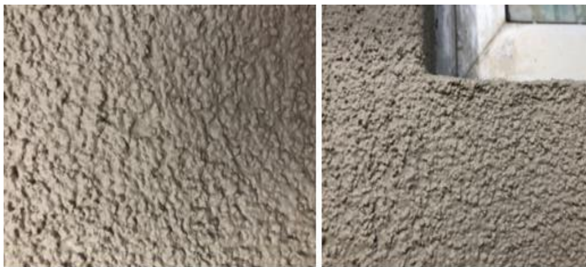
Figura 36. Acabamento final na fachada C1.
