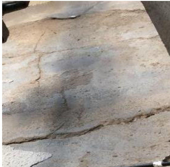
Figura 26. Fissuração horizontal.
