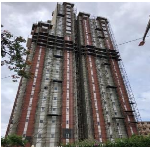
Figura 30. Estado da obra a data de início do seu estágio.
