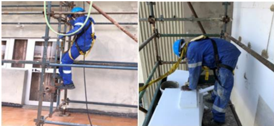
Figura 44. Operários devidamente equipados com EPI's e EPC's.
