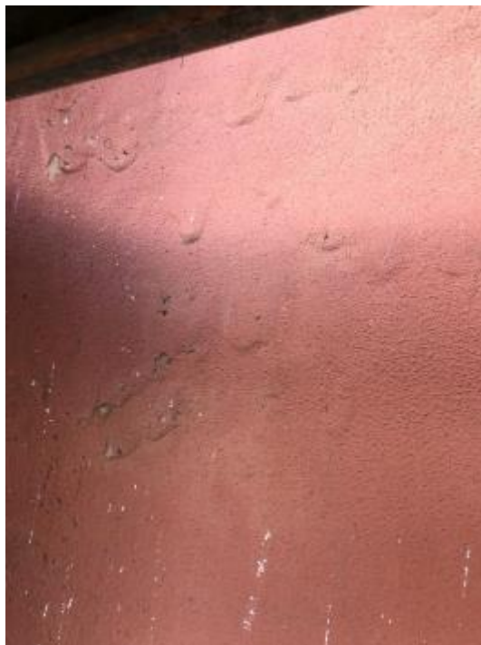
Figura 18. Eflorescência com formação de sais.
