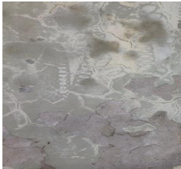
Figura 21. Fissuras mapeadas.
