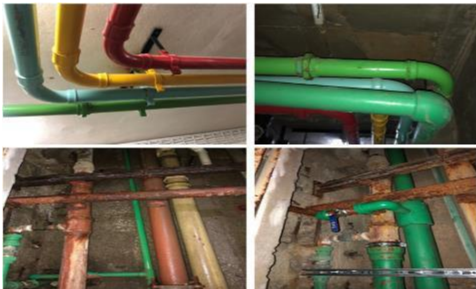
Figura 40. Substituição da tubagem e dos acessórios (1º grupo de bombagem).
