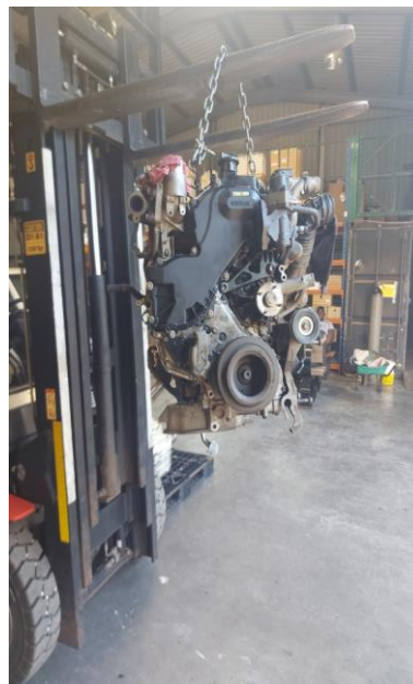
Figura 42 Motor 2.5L Nissan Troca da corrente de distribuição
