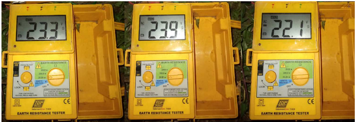
Figura 16: Medição de aterramento com espaçamento 3
