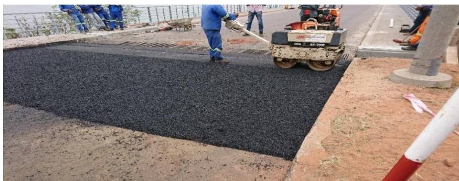
Figura 10: Compactação do pavimento
