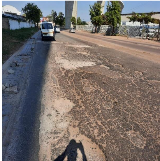
Figura 12: Patologia do tipo pele de crocodilo
