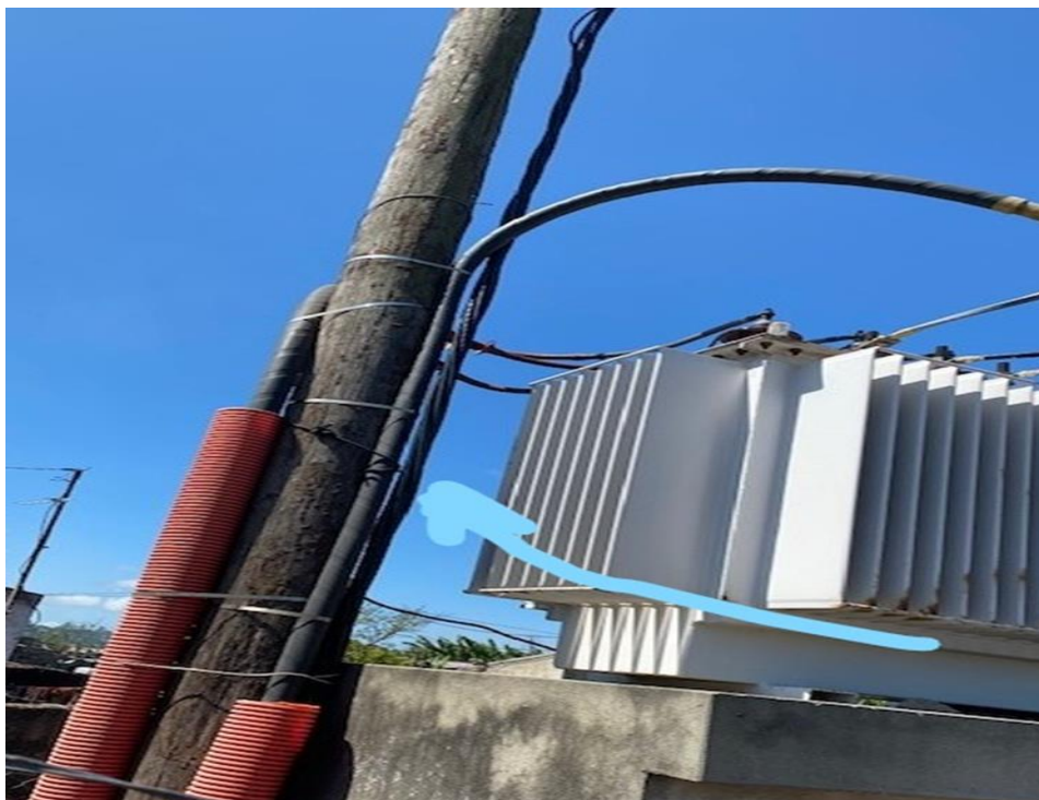
Figura 16. Ilustração do PT em sobrecarga
