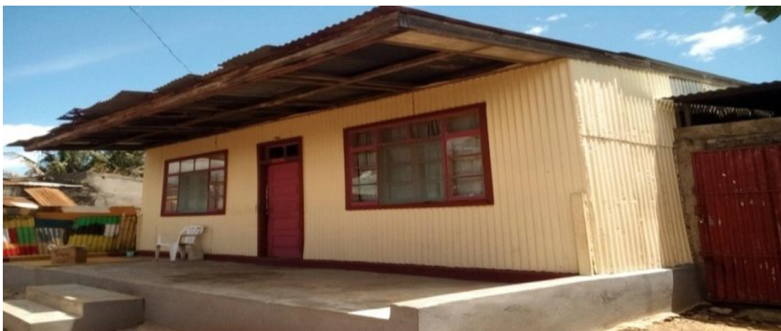
Figura 4.1. Casa de madeira e zinco.
