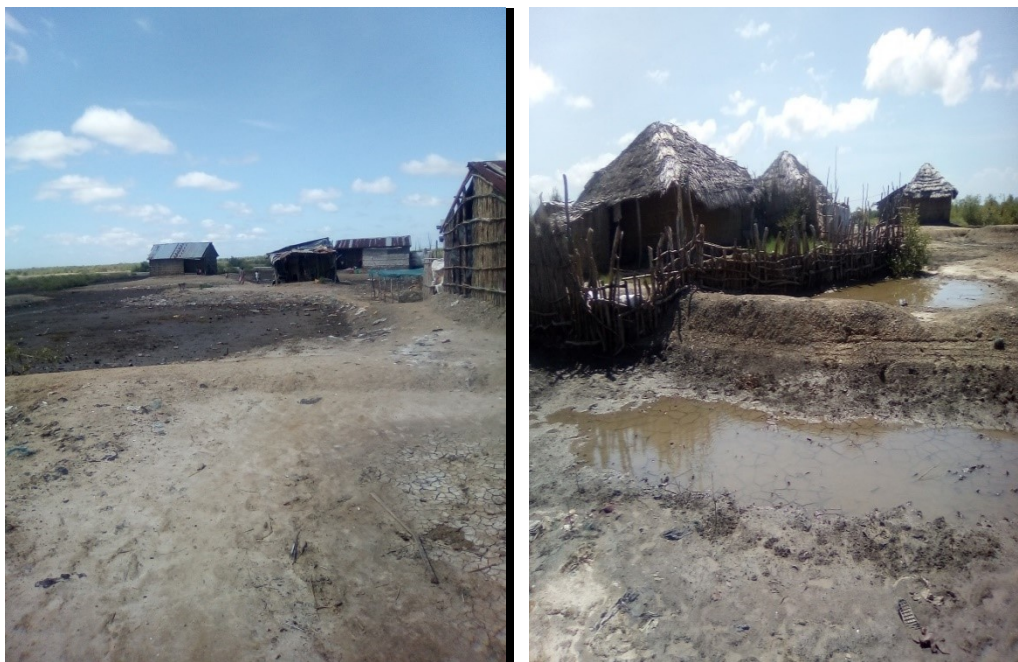
Figura 4.4: Habitações erguidas no mangal. Figura 4.5. Habitações erguidas no mangal.
