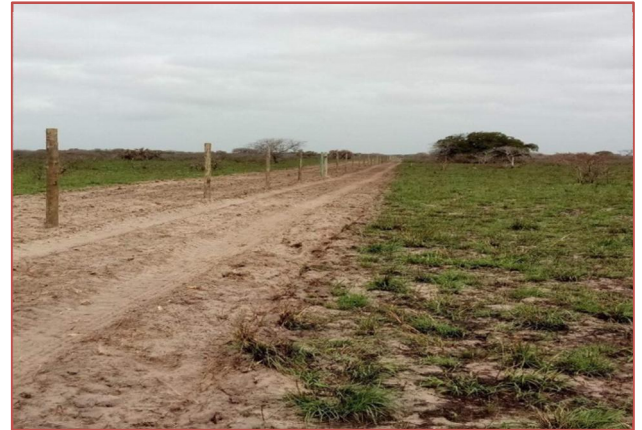
Figura 3: Aceiro de protecção aberto ao longo da vedação da REM para prevenção de incêndios florestais.
