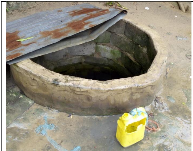
Poço 3- Bairro Inhangome
