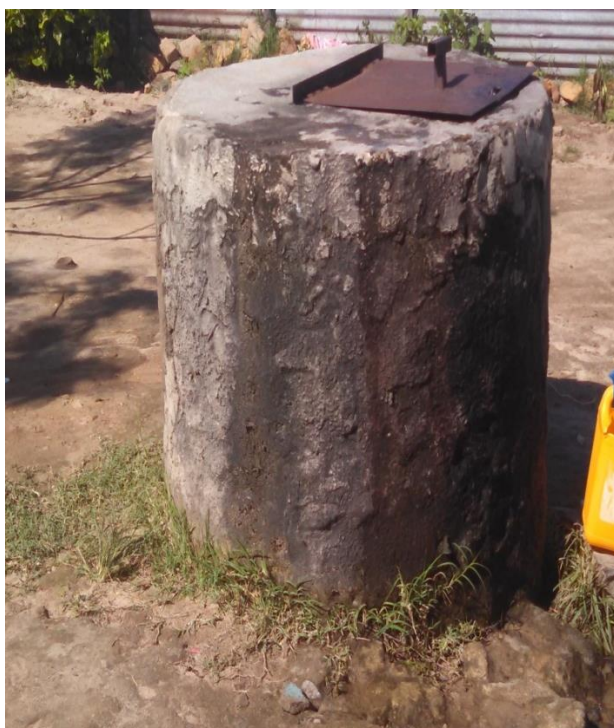
Fotografia 3. Poço 3 do bairro 25 de Setembro.
