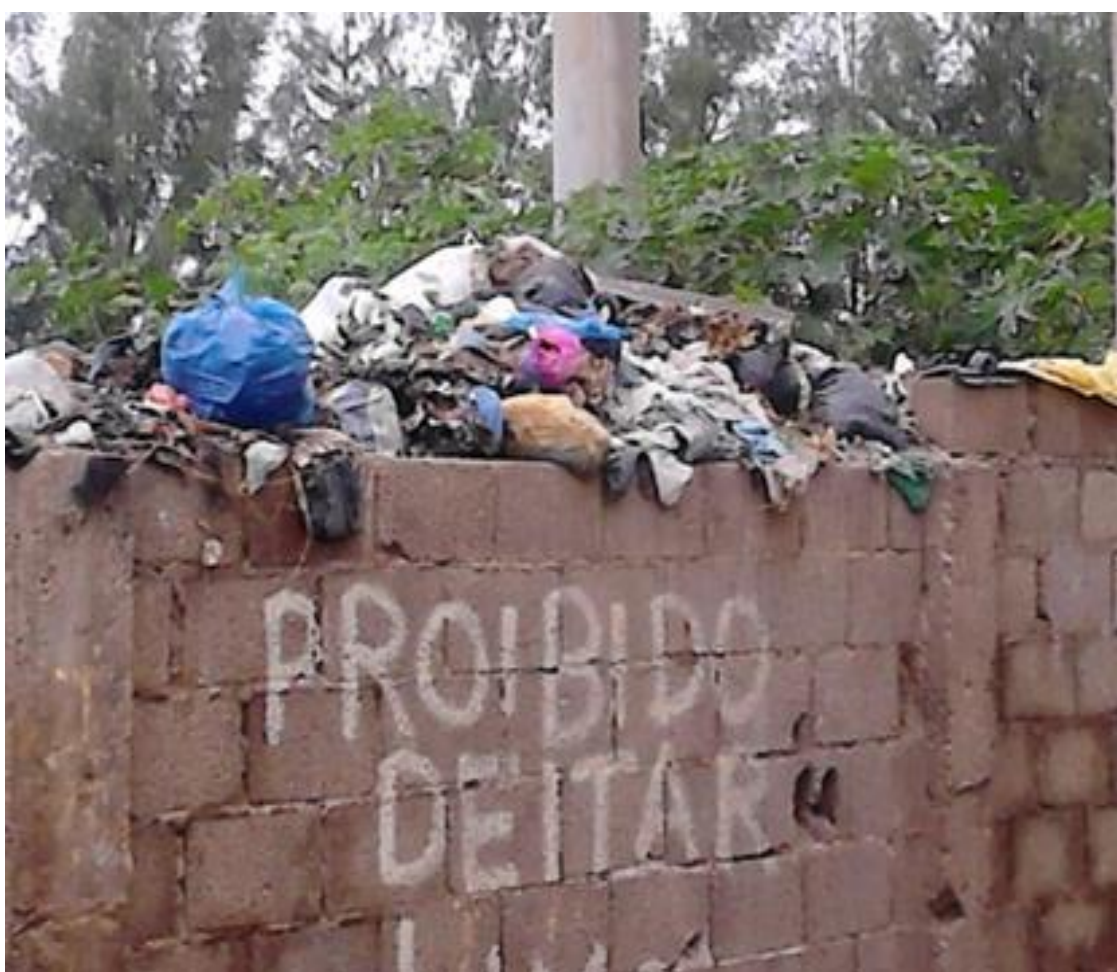
Figuras 7: Vedação e o Interio do Campus da UEM onde os Moradores Depositam o Lixo
