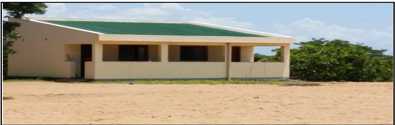
Figura – 02: Bloco sanitário.
