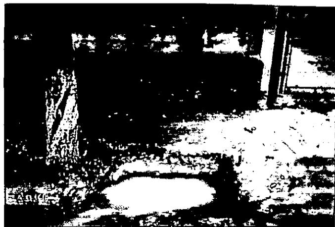
**Figura 9.** Sargeta entupida por falta de manutenção na área urbana.
